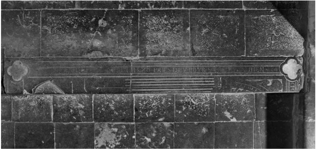
Elément de la dalle.
