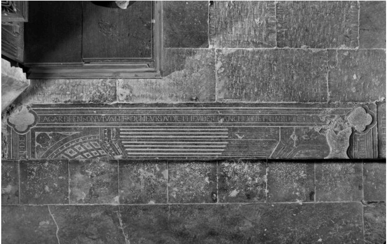
Elément de la dalle.
