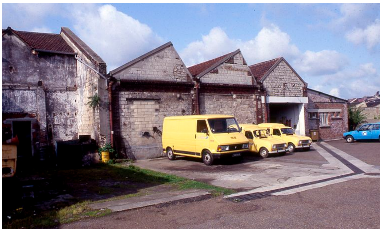
Ateliers couverts en sheds en 1992.
