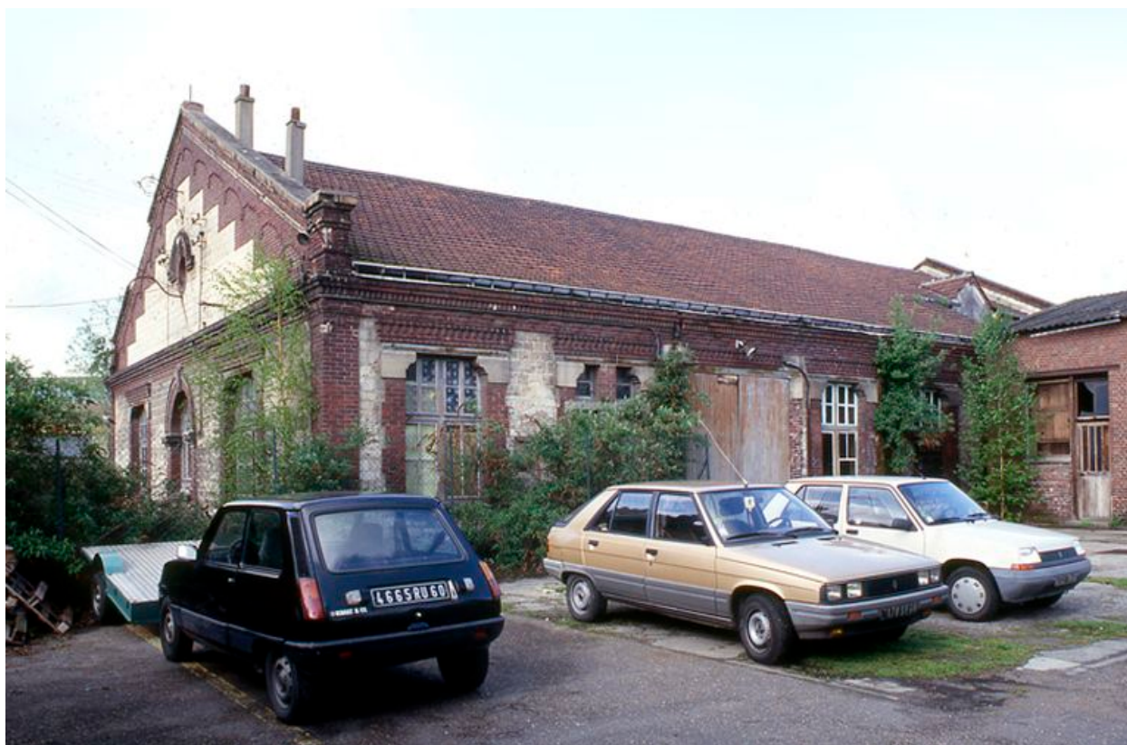
Façade est de l'atelier en 1992.
