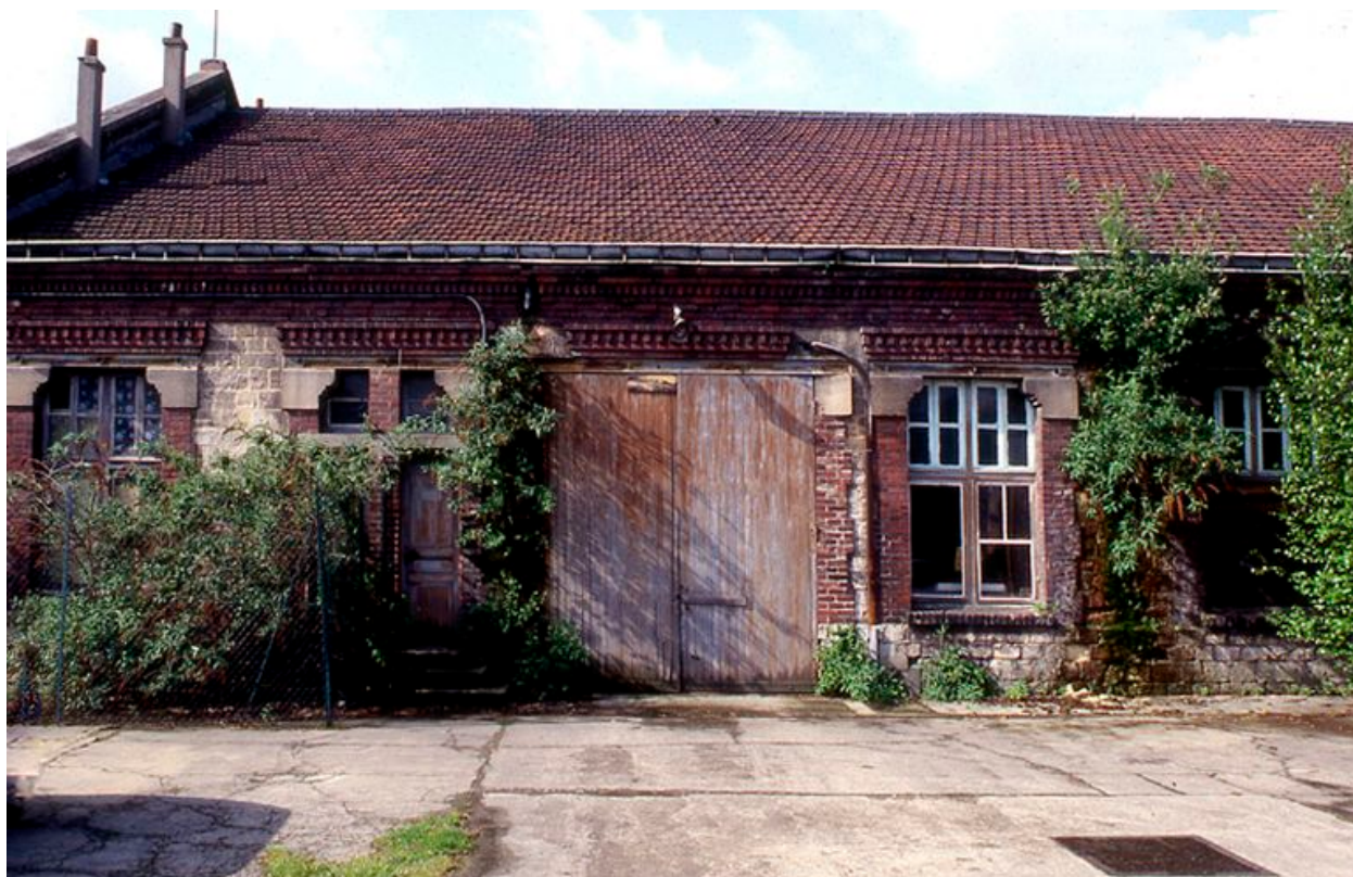
Détail des travées des ateliers.
