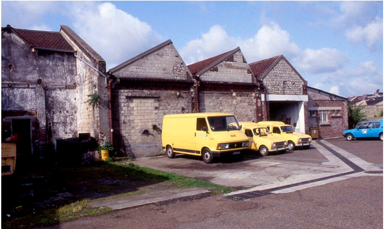
Ateliers couverts en sheds en 1992.
