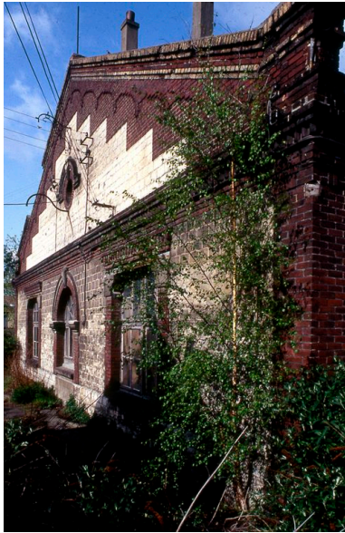
Détail du mur pignon de l'atelier en 1992. Phot. Benoît Dufournier IVR22_19926000014ZA
