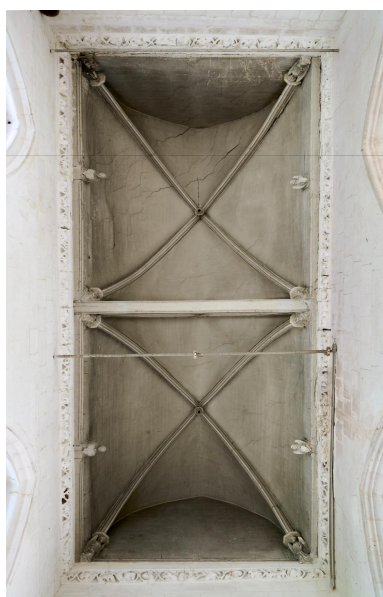
Voûte de la chapelle. Phot. Thierry Lefébure IVR32_20238000773NUCA
