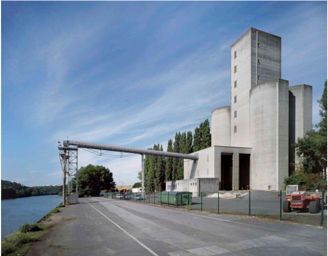
Vue générale du silo de Nogent-sur-Oise
