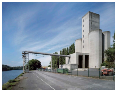
Vue générale du silo de Nogent-sur-Oise Phot. Thierry Lefébure IVR22_20106000644VA
