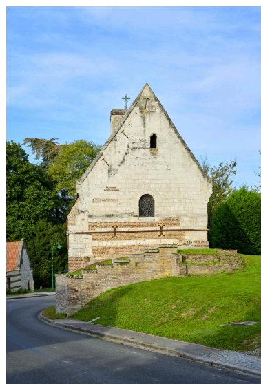
Chevet de la chapelle, depuis l'est. Phot. Thierry Lefébure IVR32_20248000162NUCA
