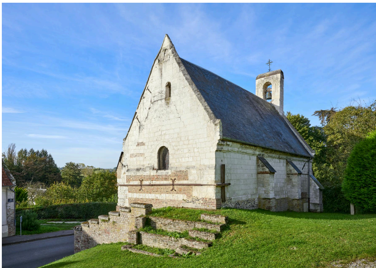
Chevet et façade nord, depuis le nord-est.
