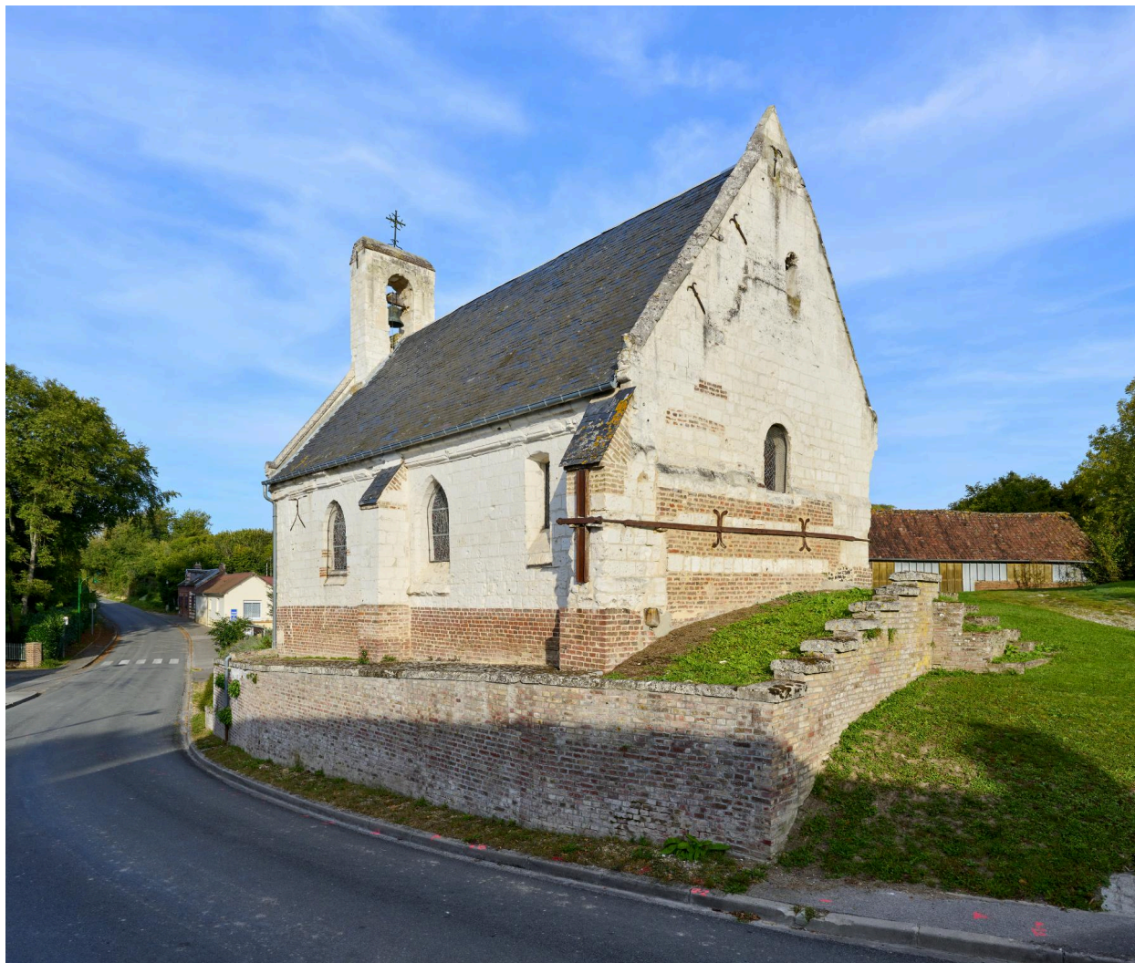
Chevet et façade sud, depuis le sud-est.
