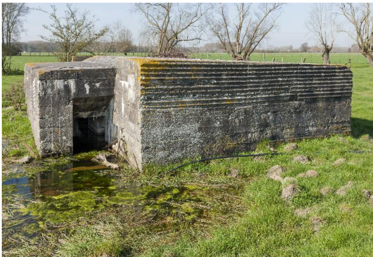
Vue vers l'ouest avec, à gauche, le porche pare-souffle
