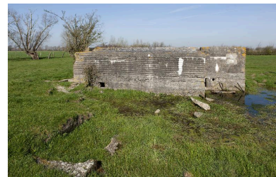
Vue latérale sud-est Phot. Jean-Marc Ramette IVR31_20145905391NUCA
