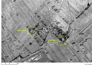
Situation de l'édifice (à gauche) sur une photographie aérienne britannique du 15/09/1918 Phot. Jean-Marc Ramette IVR32_20175900903NUCA
