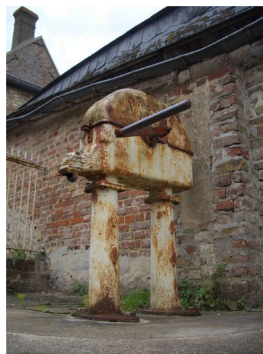
Vue de la pompe à incendie, rue de la Somme. Phot. Inès Guérin IVR22_20068005548NUCA
