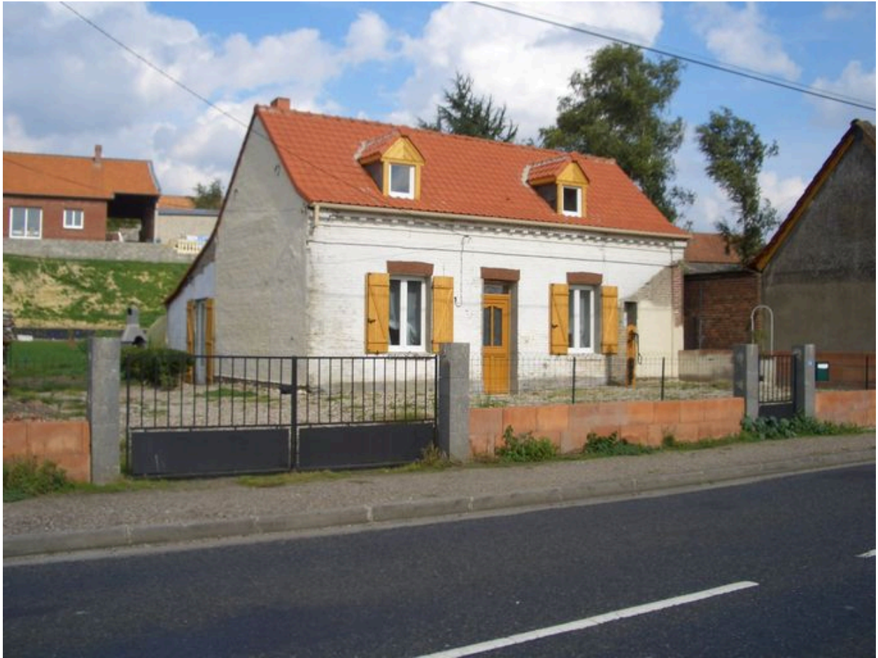
Maison, 19 rue de la Baie, fin 19e siècle ( 1984 B 361).
