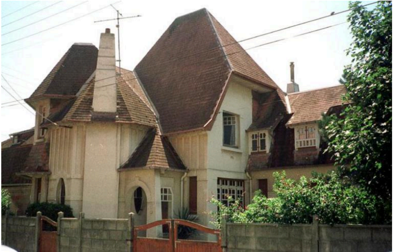
Vue d'ensemble de l'angle de la villa.
