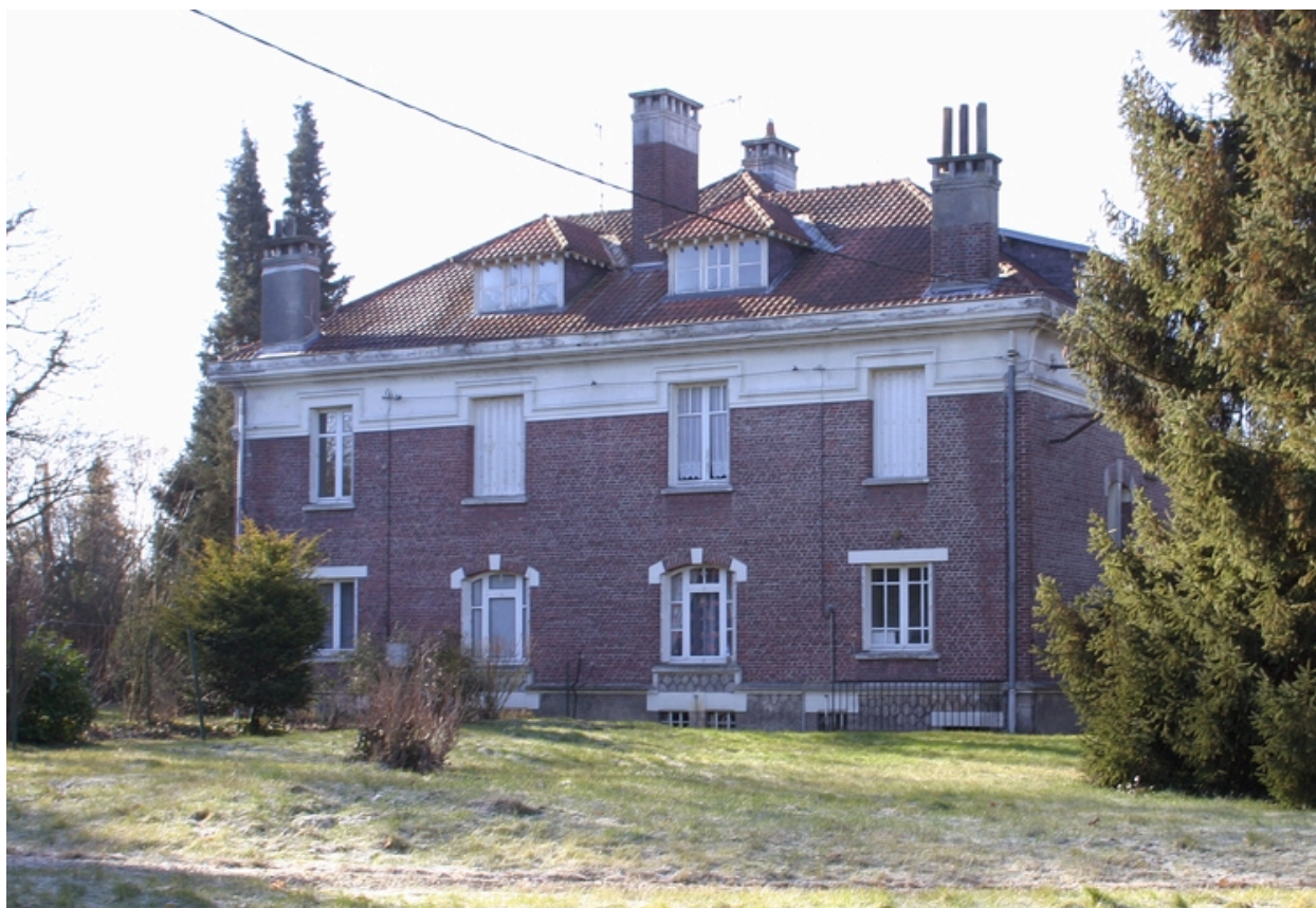
Bâtiment à deux logements de 1926-1928, façade postérieure.
