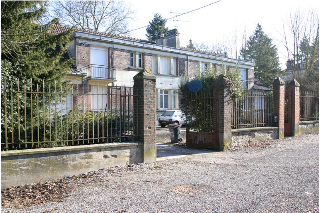
Bâtiment à deux logements de 1940.
