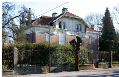
Bâtiment à deux logements de 1926-1928, façade antérieure. Phot. Frédéric Pillet IVR22_20060205230NUCA
