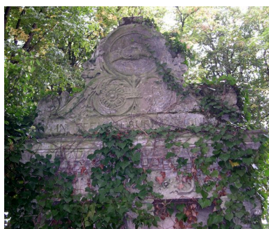
Vue de détail du fronton. Phot. Isabelle Barbedor IVR22_20078010246NUCA
