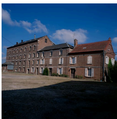
La minoterie et le logement d'habitation. Phot. Thierry Lefébure IVR22_20026001020XA
