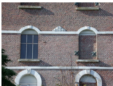
Détail de l'élévation postérieure portant les initiales GD et la date de 1864.
