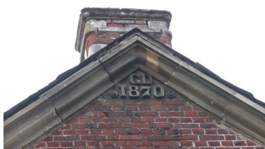
Détail des initiales GD et de la date de 1870 portées sur le pignon ouest du magasin à grains. Phot. Bertrand Fournier IVR22_20026001044NUCA
