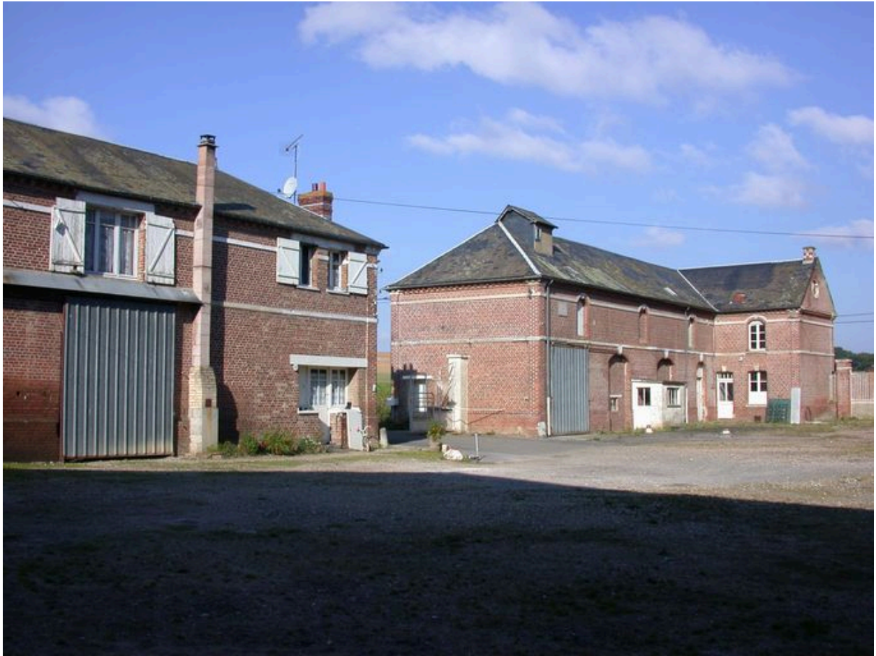
Les anciennes écuries et l'entrepôt à grains, façade sur cour.
