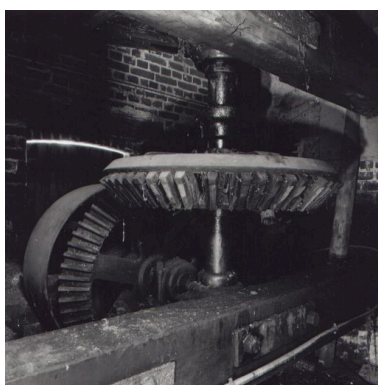
Intérieur de la salle de turbine, détail des engrenages de transmission.
