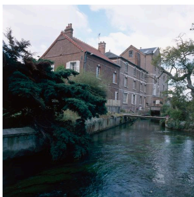
Vue d'ensemble postérieure depuis la rivière.
