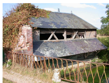
Le lavoir. Phot. Bertrand Fournier IVR22_20026001039NUCA
