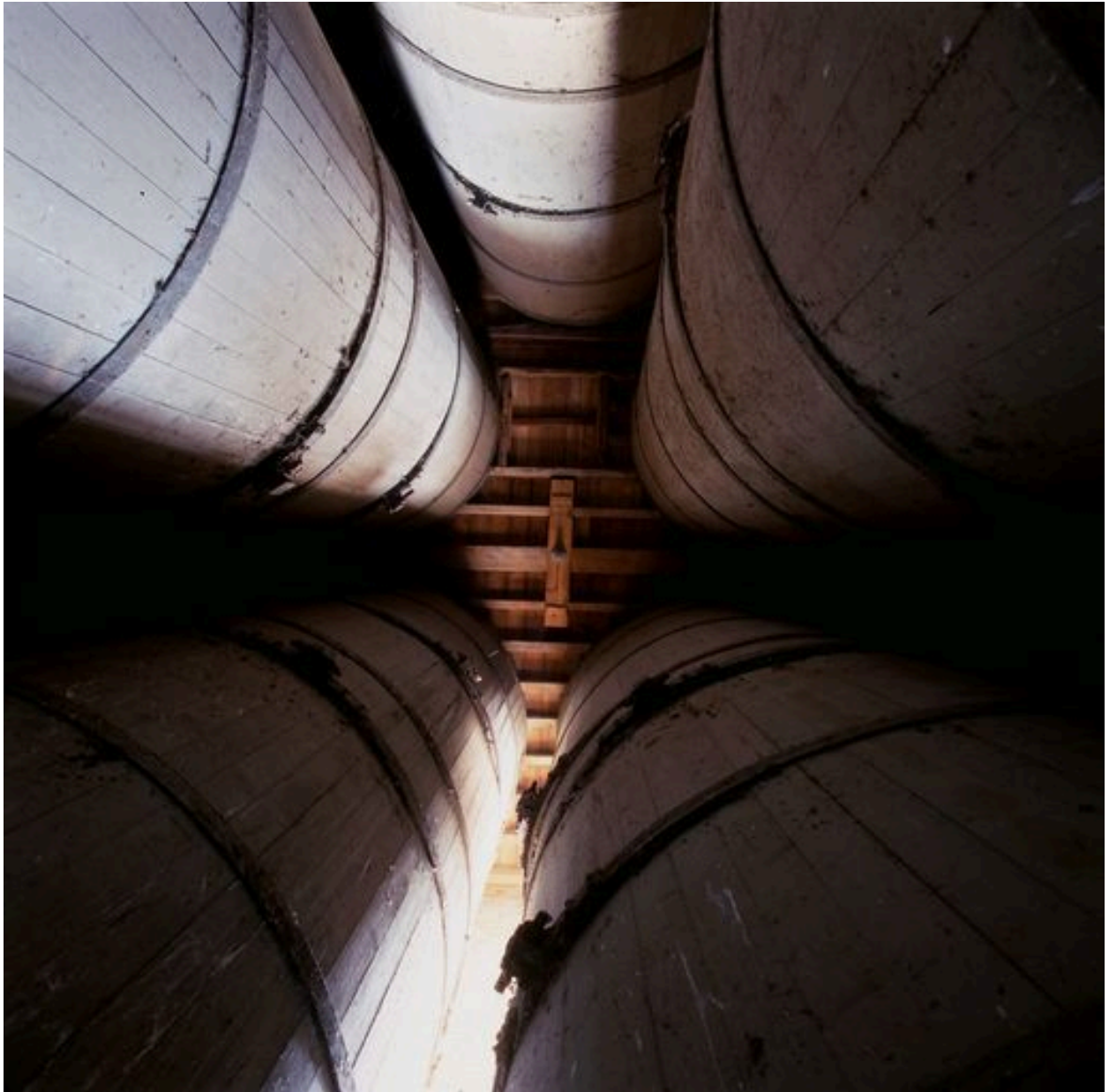
Vue d'ensemble des cinq silos cylindriques en bois.
