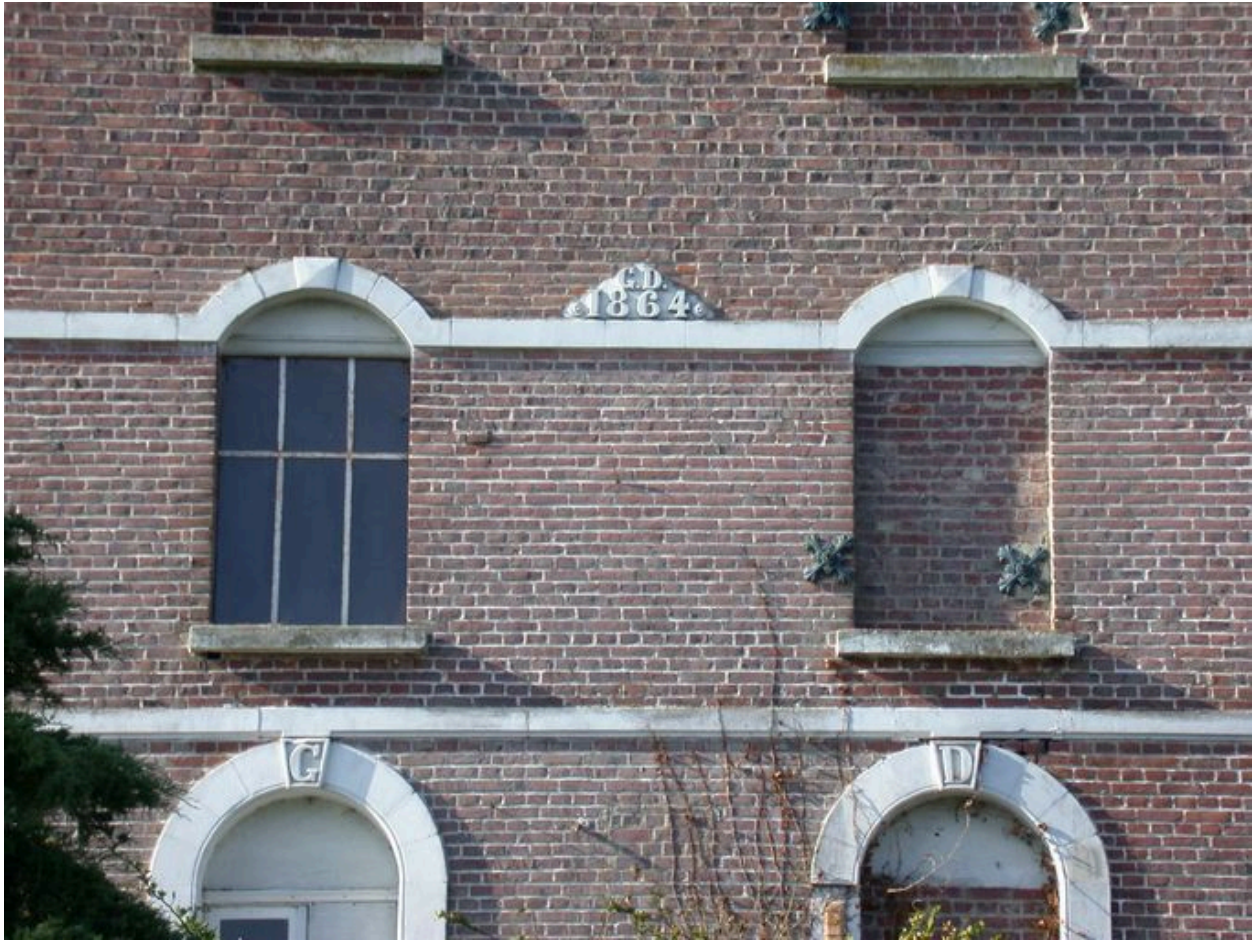
Détail de l'élévation postérieure portant les initiales GD et la date de 1864.
