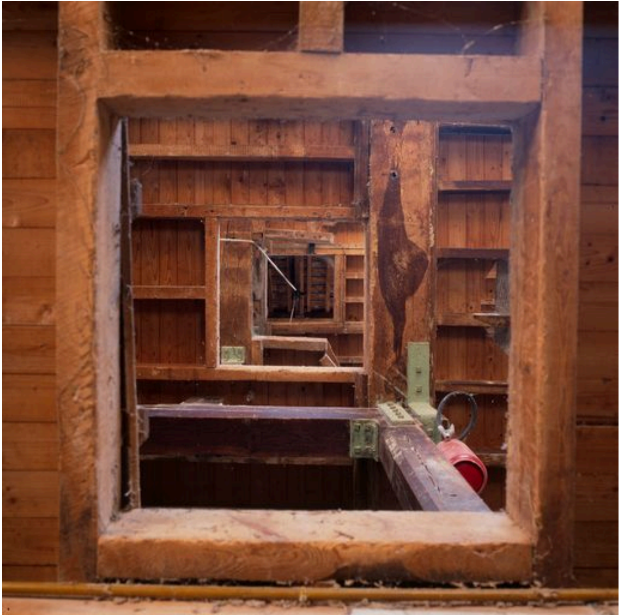
Élévation intérieure de la minoterie depuis la trappe monte-sac.
