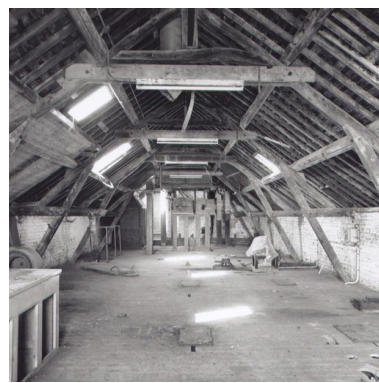
Vue intérieure des combles de la minoterie.
