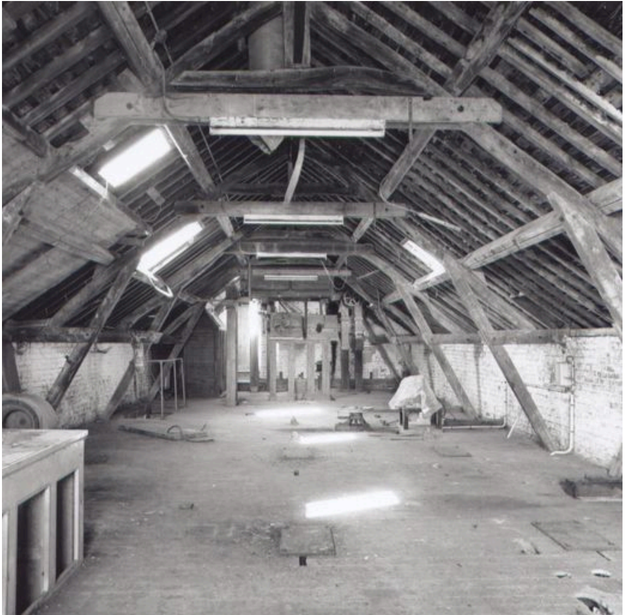
Vue intérieure des combles de la minoterie.
