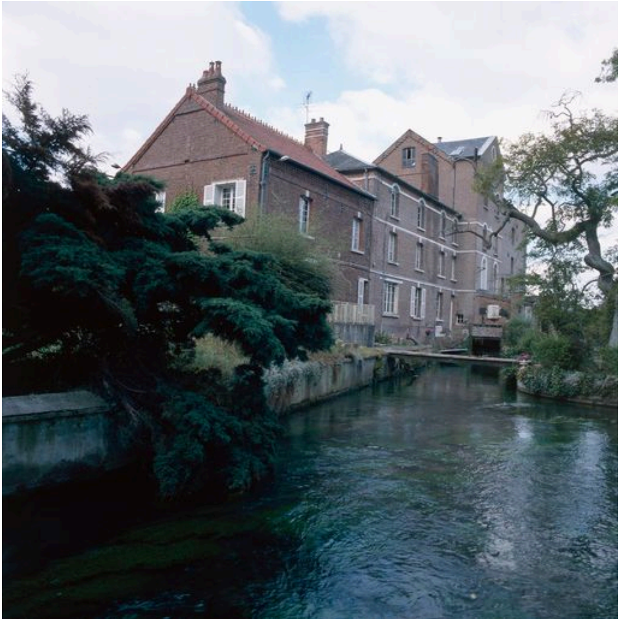
Vue d'ensemble postérieure depuis la rivière.
