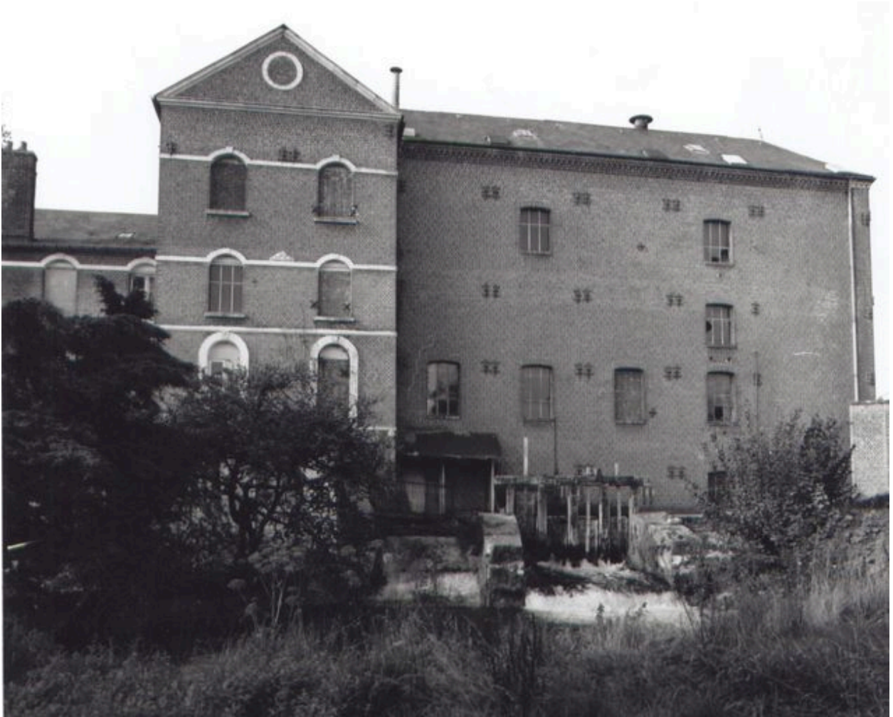
Façade postérieure de la minoterie.
