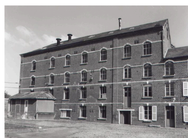
Vue d'ensemble du bâtiment de minoterie, façade sur cour. Phot. Thierry Lefébure IVR22_20026000893X
