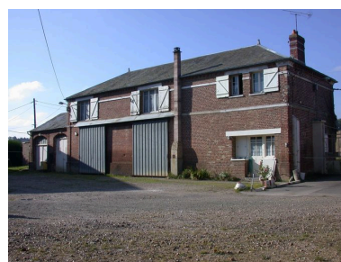
Les écuries converties en logement d'habitation. Phot. Bertrand Fournier IVR22_20026001032NUCA
