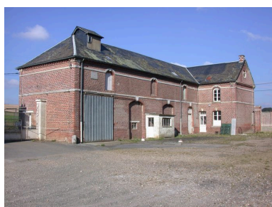
Logement du meunier et entrepôt industriel, façade sur cour. Phot. Bertrand Fournier IVR22_20026001031NUCA
