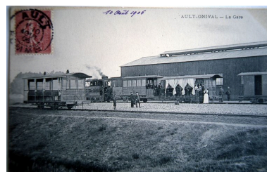
La gare d'Onival, détruite, située à l'emplacement du camping de la Chapelle, carte postale, 1 er quart 20 e siècle (coll. part.). Phot. Monnehay-Vulliet Marie-Laure IVR22_20058000641XAB
