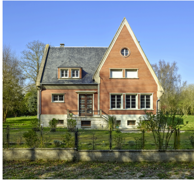
Vue de la maison, depuis l'est. Phot. Thierry Lefébure IVR32_20258001600NUCA
