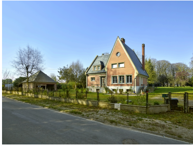
Vue de la maison, depuis le nord. Phot. Thierry Lefébure IVR32_20258001603NUCA
