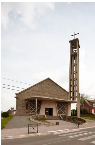
Vue de la façade. Phot. Hubert Bouvet IVR31_20106200696NUCA
