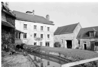
Vue générale. Phot. Benoît Dufournier IVR22_19946000185Z
