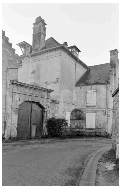
Élévation antérieure, portail. Phot. Benoît Dufournier IVR22_19946000187Z
