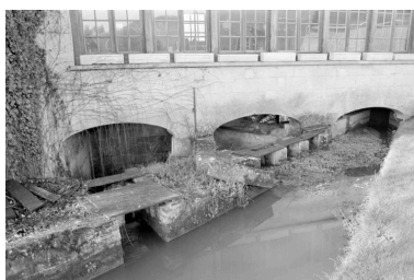
Voies d'eau. Phot. Benoît Dufournier IVR22_19946000186Z
