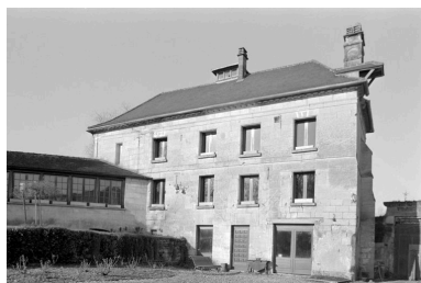
Vue générale. Phot. Benoît Dufournier IVR22_19946000184Z
