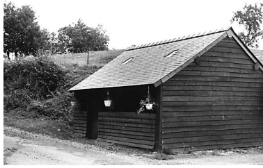
Lavoir, impasse des Echevets. Phot. Xavier-Philippe Guiochon IVR22_19970202620Z
