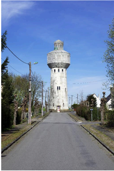
Vue de situation. Phot. Thierry Lefébure IVR32_20170200159NUC2A
