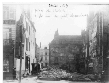
Vue des ruines de l'immeuble du 23 place du Théâtre.
