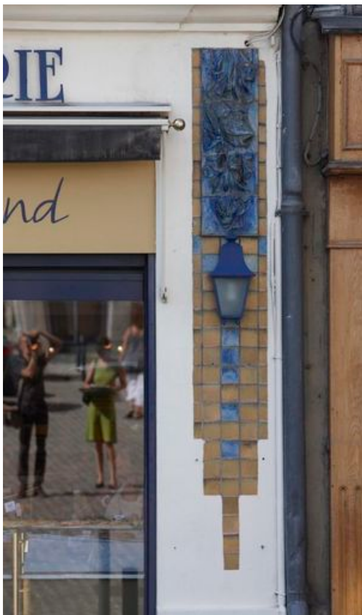
Vue d'une guirlande de céramique disposée en chute sur la partie latérale droite du rez-de-chaussée.
