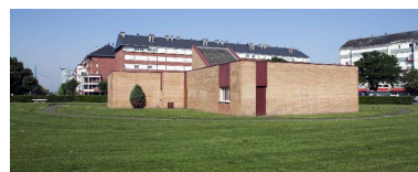
Élévation latérale gauche et façade postérieure. Phot. Pierre Thibaut IVR31_20155900254NUCA
