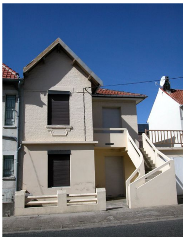
Le logis, élévation antérieure. Phot. Elisabeth Justome IVR22_20058002742NUCA
