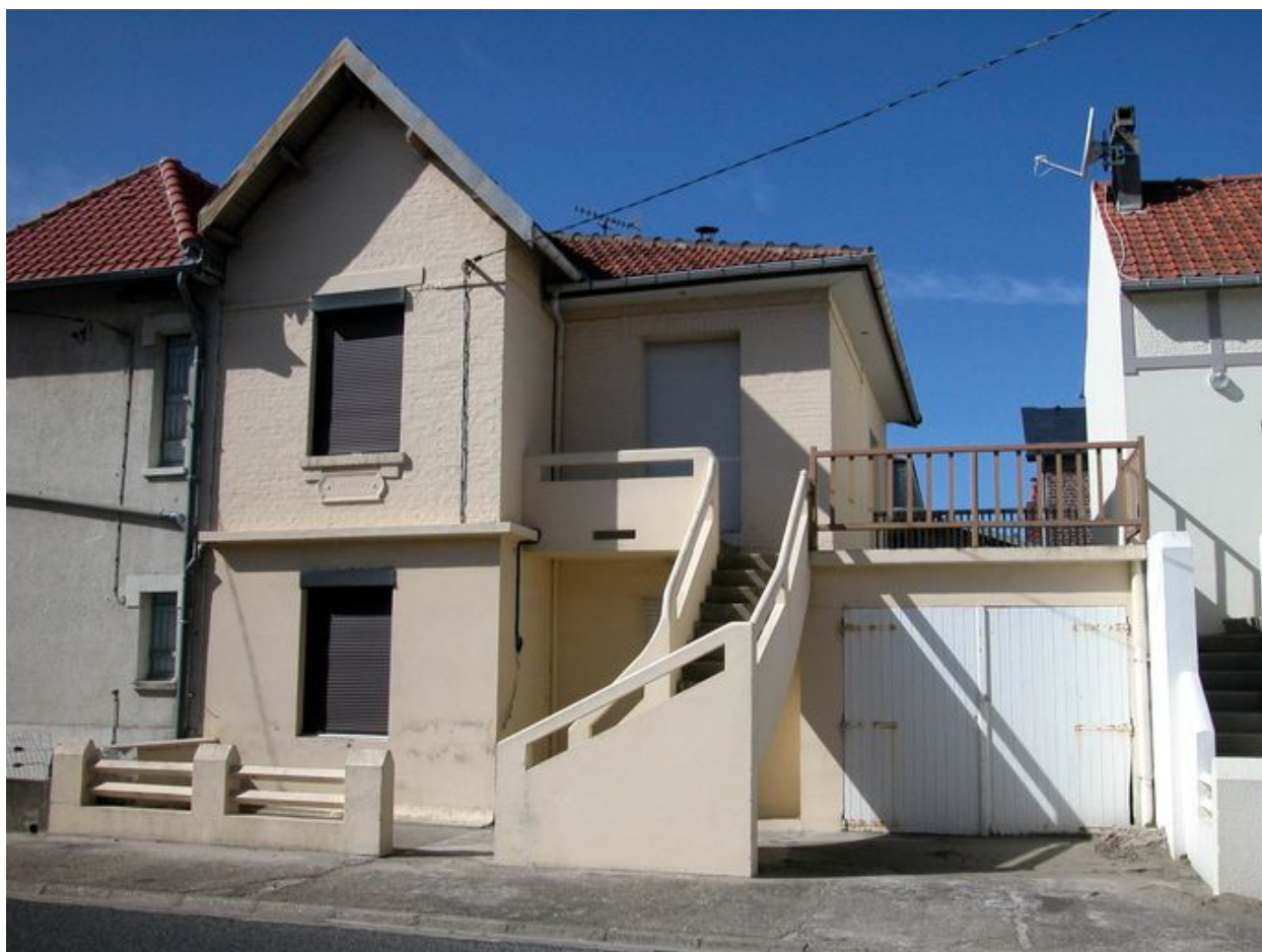
Vue d'ensemble avec le garage accolé.
