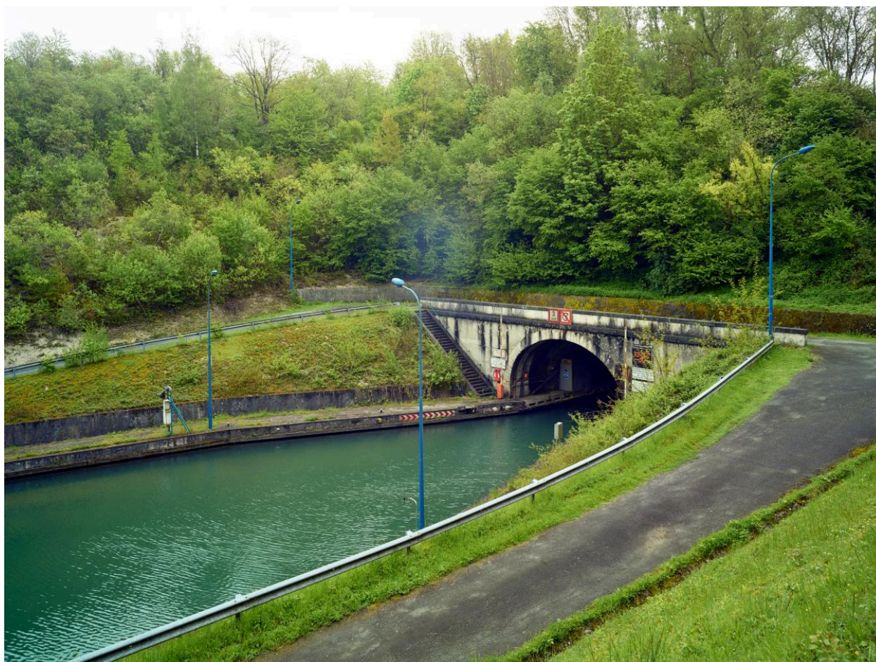
Tête nord et voie de circulation.
