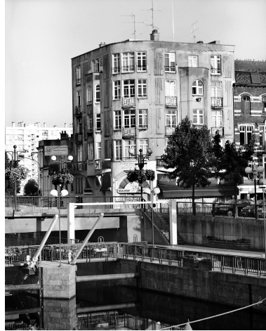
Vue générale de l'immeuble Lecluyse.
