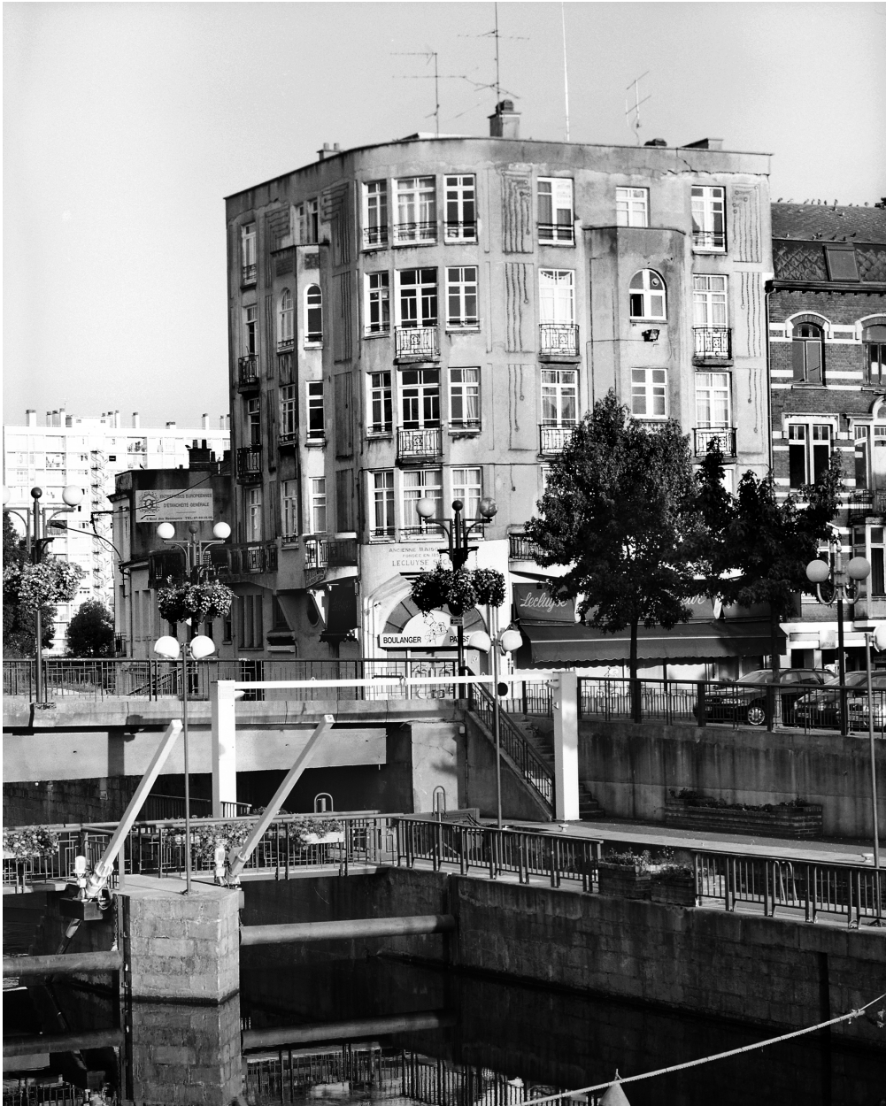
Vue générale de l'immeuble Lecluyse.
