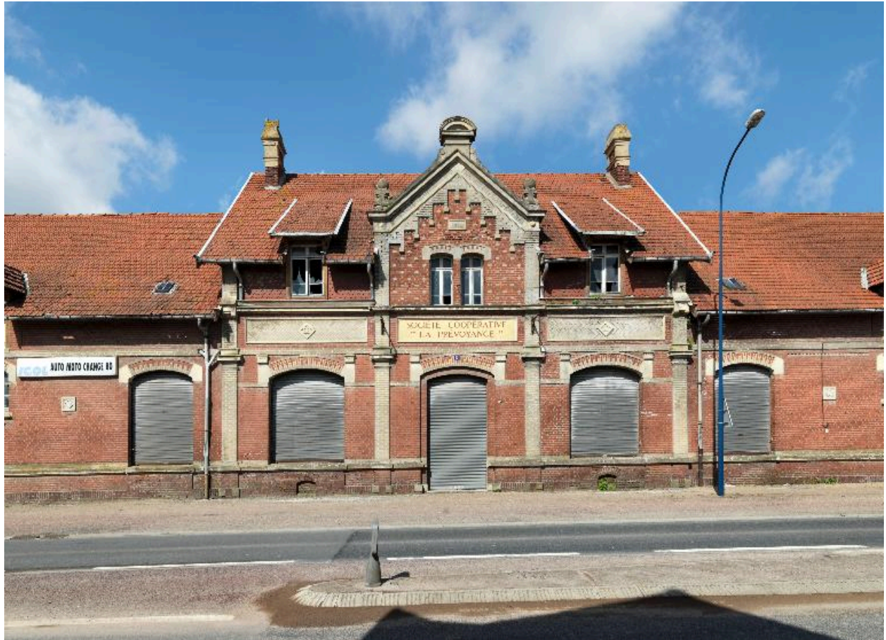
Façade sur rue, vue de face.
