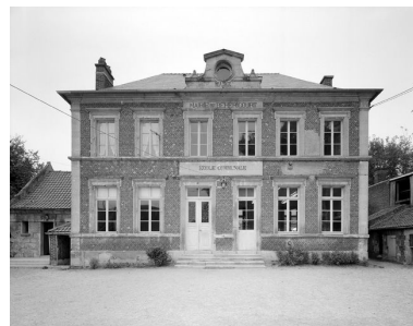
Vue générale. Phot. Jean-Michel Perrin IVR22_19846001225V
