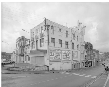
Vue de trois quarts. Phot. Olivier Marlard IVR31_19925901608V
