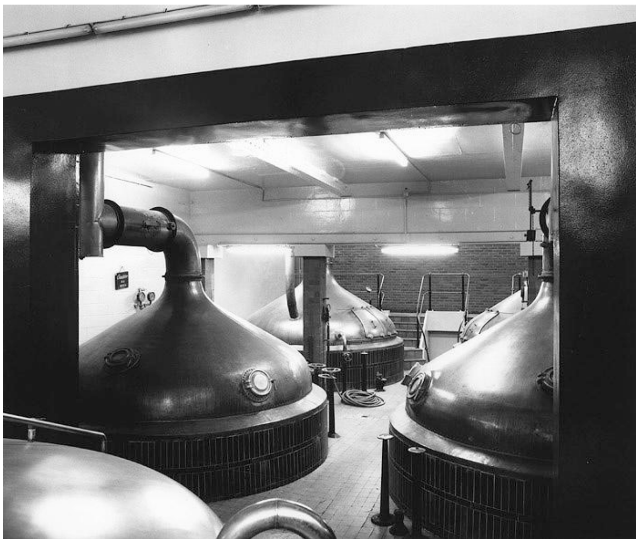
Salle de brassage, vue générale.
