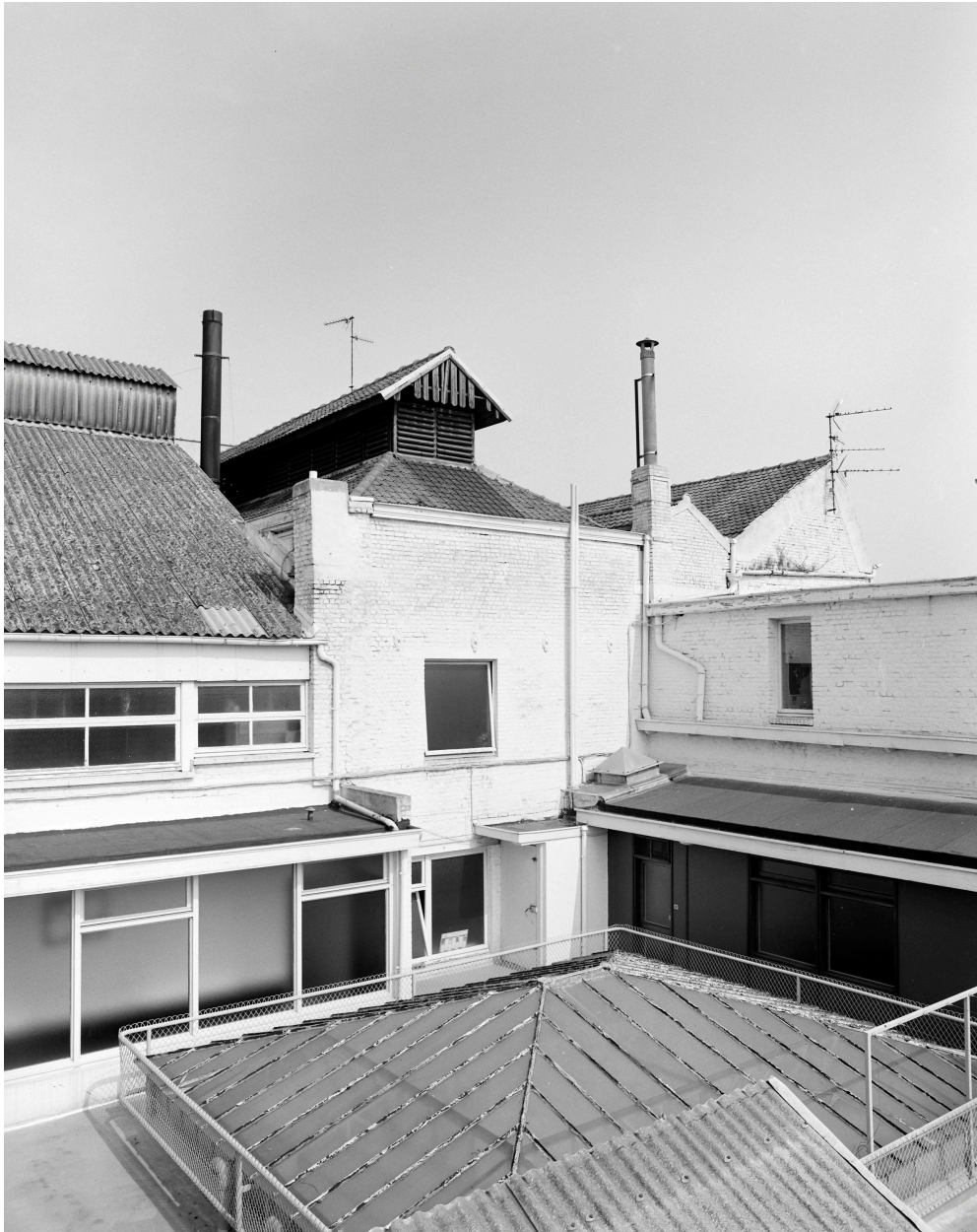
Atelier de fabrication (refroidissement de la bière) antérieur à 1920.
