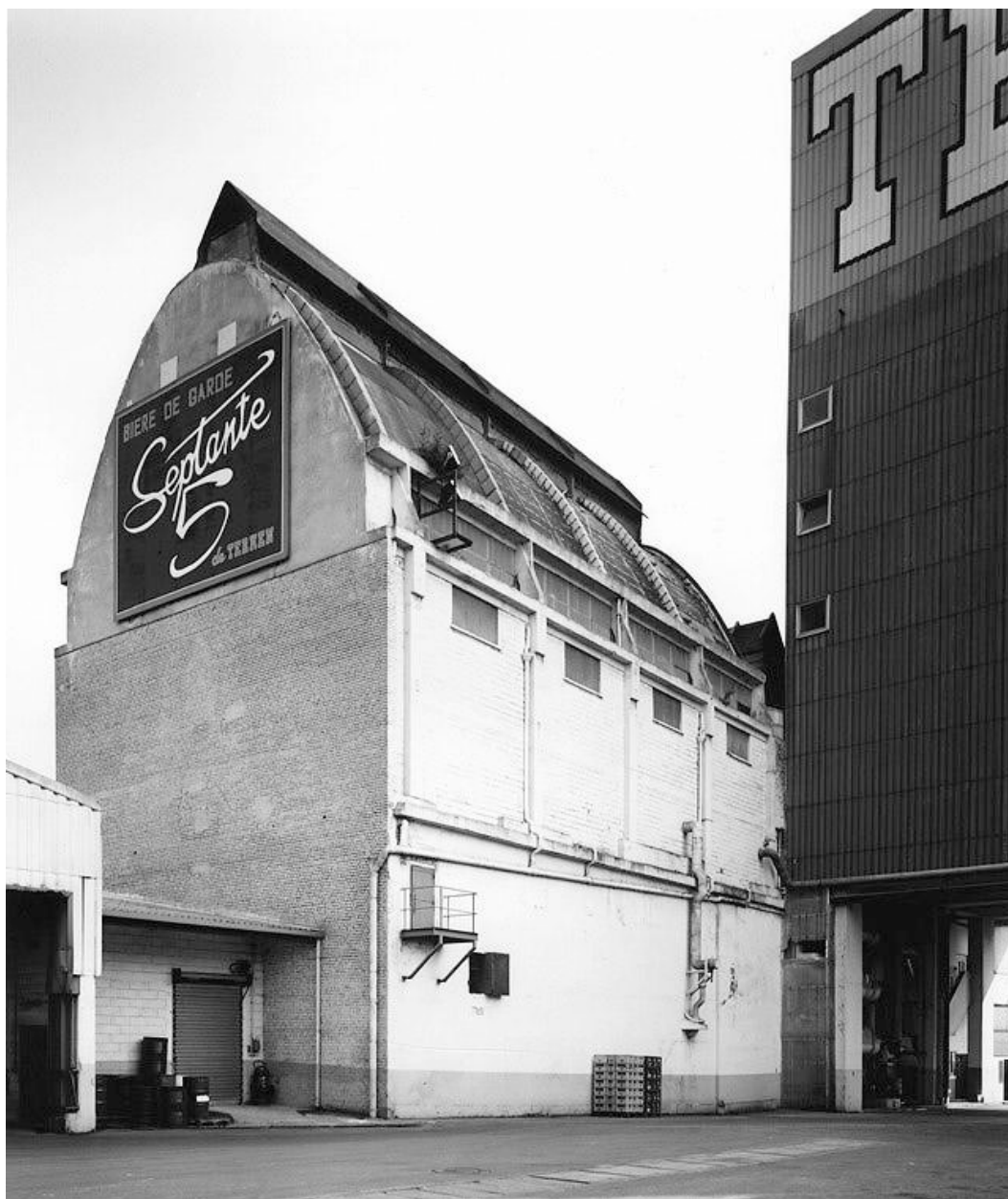
Atelier de fabrication (refroidissement de la bière), vue de trois quarts.
