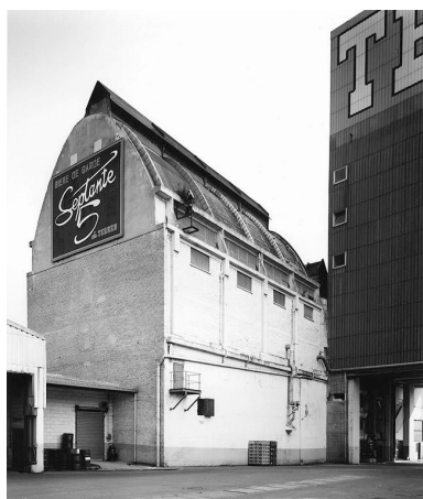
Atelier de fabrication (refroidissement de la bière), vue de trois quarts. Phot. Thierry Petitberghien IVR31_19915900552V
