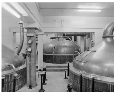
Salle de brassage, vue générale. Phot. Thierry Petitberghien IVR31_19915900558X
