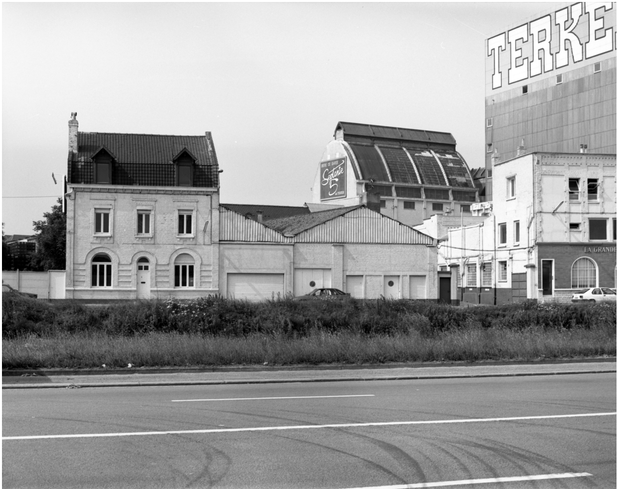
Logement patronal (avant 1920), élévation antérieure.
