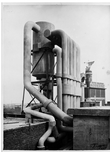
Installation frigorifique extérieure : système flooded (séparateur liquide-gaz) (AP Coutances). Repro. Thierry Petitberghien IVR31_19915900527XB
