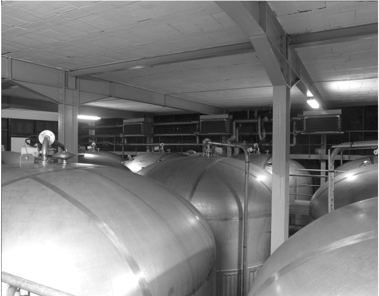
Salle de fermentation, niveau supérieur.
