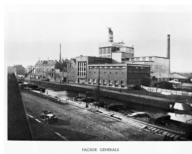
Vue générale avant 1940 (AP Coutances). Repro. Thierry Petitberghien IVR31_19915900506XB
