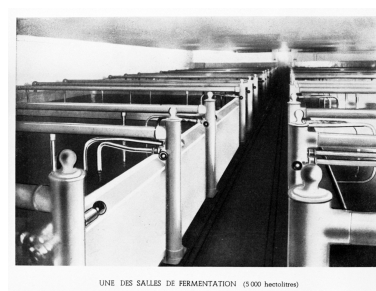
Salle de fermentation, cuves ouvertes (5000 hl) (AP Coutances). Repro. Thierry Petitberghien IVR31_19915900508XB
