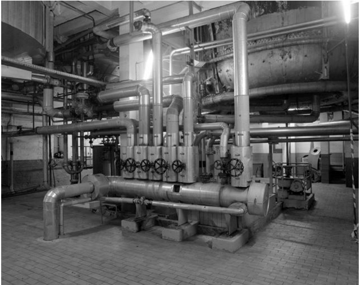
Atelier de fabrication, niveau inférieur : base des cuves.
