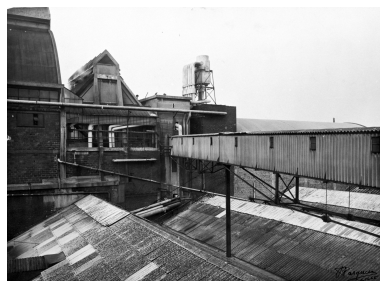
Bâtiment de refroidissement de la bière (AP Coutances). Repro. Thierry Petitberghien IVR31_19915900526XB
