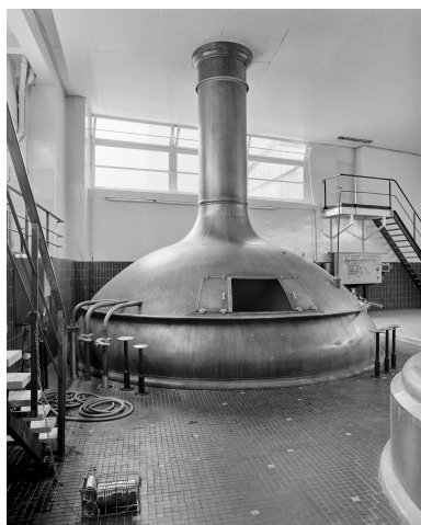
Salle de brassage, cuve à ébullition. Phot. Thierry Petitberghien IVR31_19915900556X
