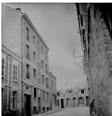
A gauche, façade antérieure de l'immeuble de la rue de Colmar. Au fond, la Cité de Mulhouse (IFA). Phot. Pillet Frédéric IVR22_20040201148NUCAB
