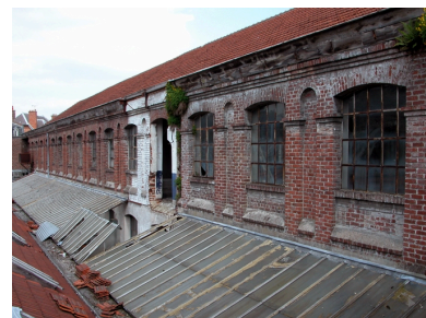
Façade postérieure des ateliers de fabrication de guipure, construits en 1887. Phot. Frédéric Pillet IVR22_20040200756NUCA
