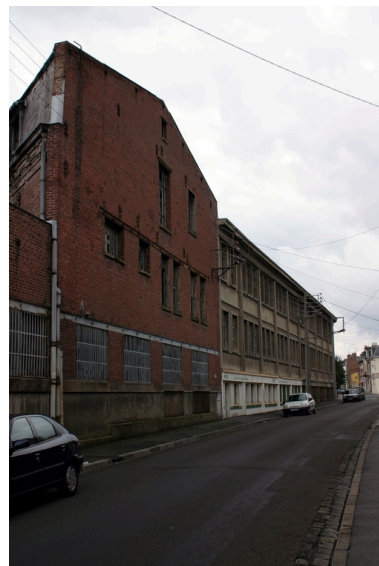
Ateliers rue Camille-Desmoulins.
