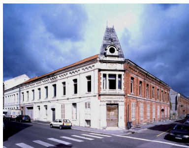
Les ateliers bordant la rue Richard- Lenoir, construits à partir de 1887. Phot. Thierry Lefébure IVR22_20070200080VA
