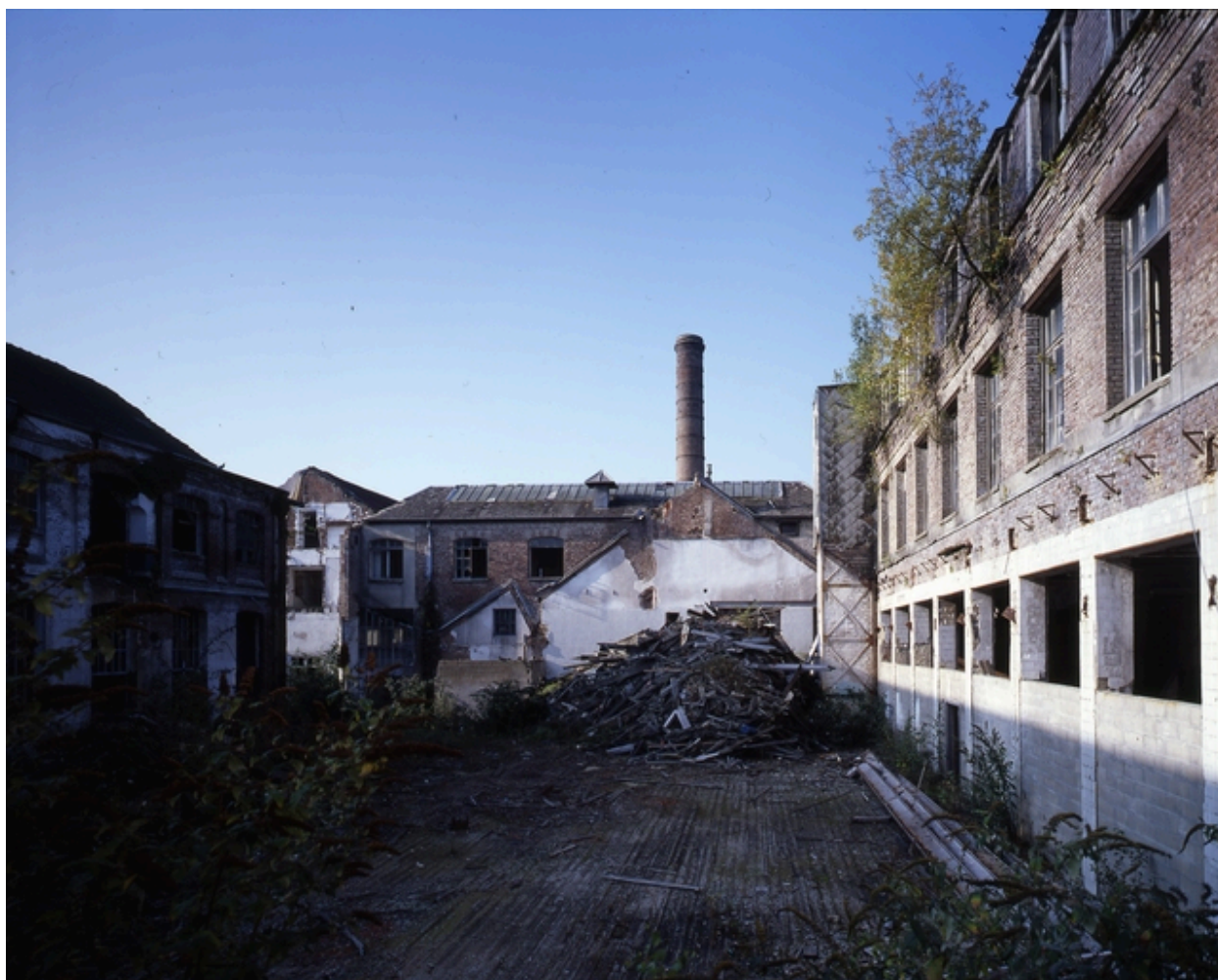
Vue des bâtiments en cours de démolition.
