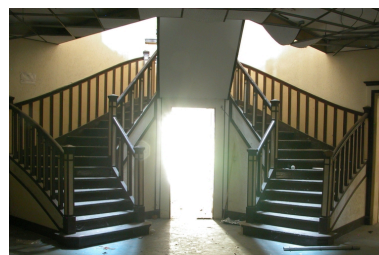
Escalier implanté à l'angle des rues de Mulhouse et Richard-Lenoir, rez-de-chaussée.
