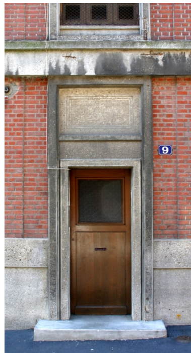
Entrée de l'immeuble d'habitation, rue de Colmar. Phot. Frédéric Pillet IVR22_20040201194NUCA
