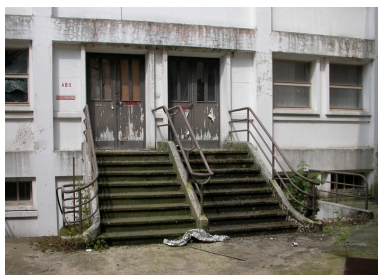
Escaliers dans la cour de l'usine.
