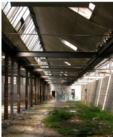
Atelier de préparation (fabrication de la guipure) reconstruit à l'issue de la Première Guerre mondiale.
