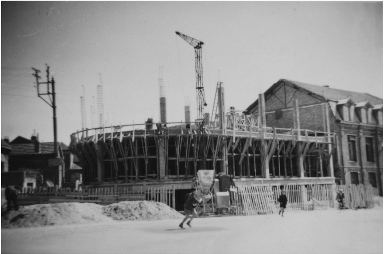
Chantier de construction des ateliers, 1948 (IFA).
