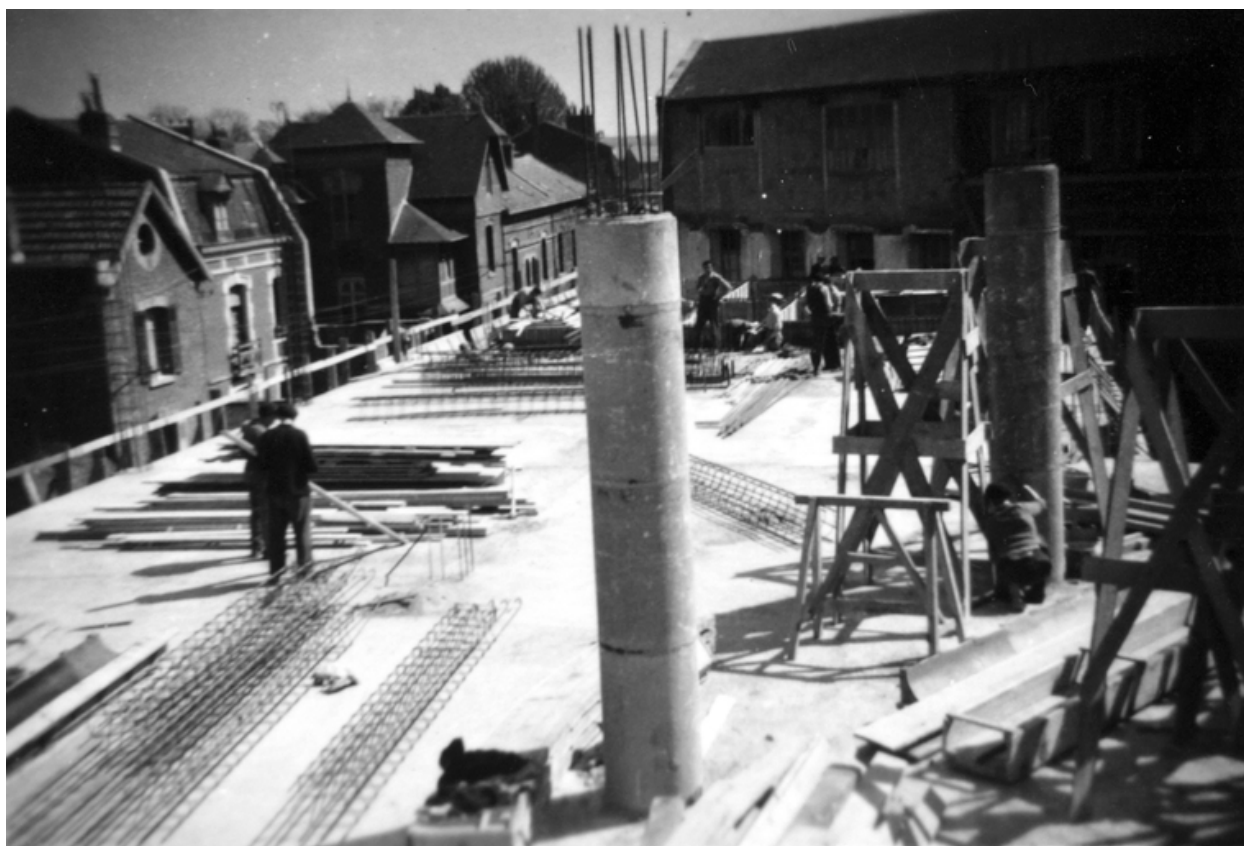
Chantier de construction des ateliers, 1948 (IFA).
