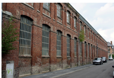
Façade des ateliers construits en 1887, rue Richard-Lenoir : atelier de fabrication de la guipure depuis 1887 (rez-de-chaussée), magasin des piqués et des échantillons (1er étage).
