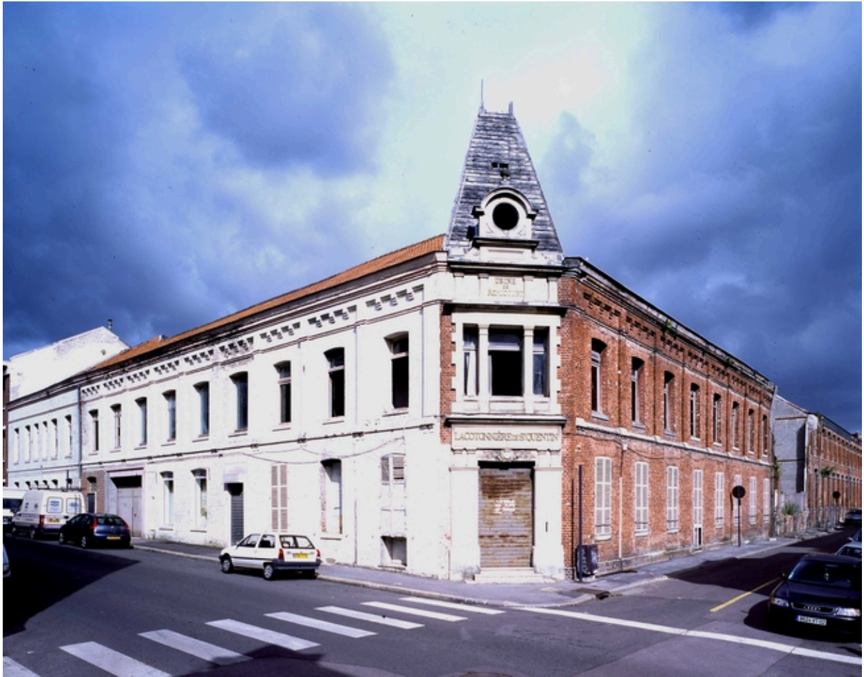
Les ateliers bordant la rue Richard-Lenoir, construits à partir de 1887.
