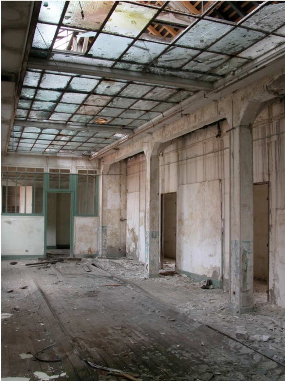
Vue intérieure du Cabinet de fabrication, couvert d'une verrière.
