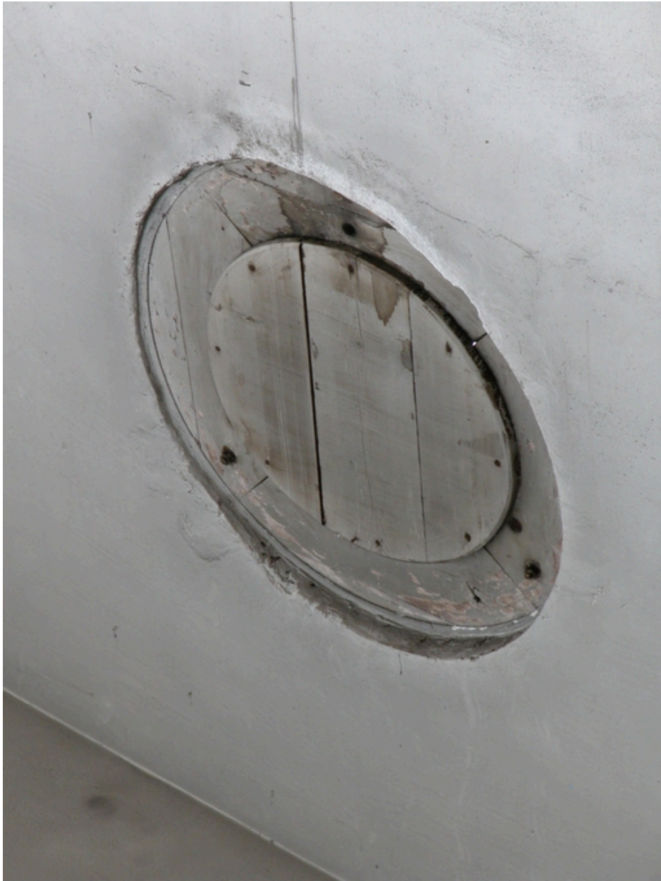
Oculus permettant la ventilation des ateliers de fabrication de la guipure (sous sheds) reconstruits après la Première Guerre mondiale.
