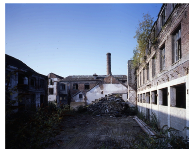
Vue des bâtiments en cours de démolition. Phot. Thierry Lefébure IVR22_20070200065VA
