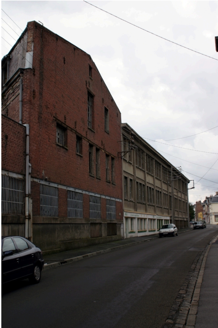
Ateliers rue Camille-Desmoulins.
