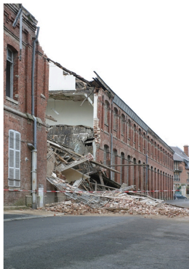
Effondrement d'une partie des ateliers de tissage, rue Richard-Lenoir, en janvier 2005. Phot. Frédéric Pillet IVR22_20050205596NUCA
