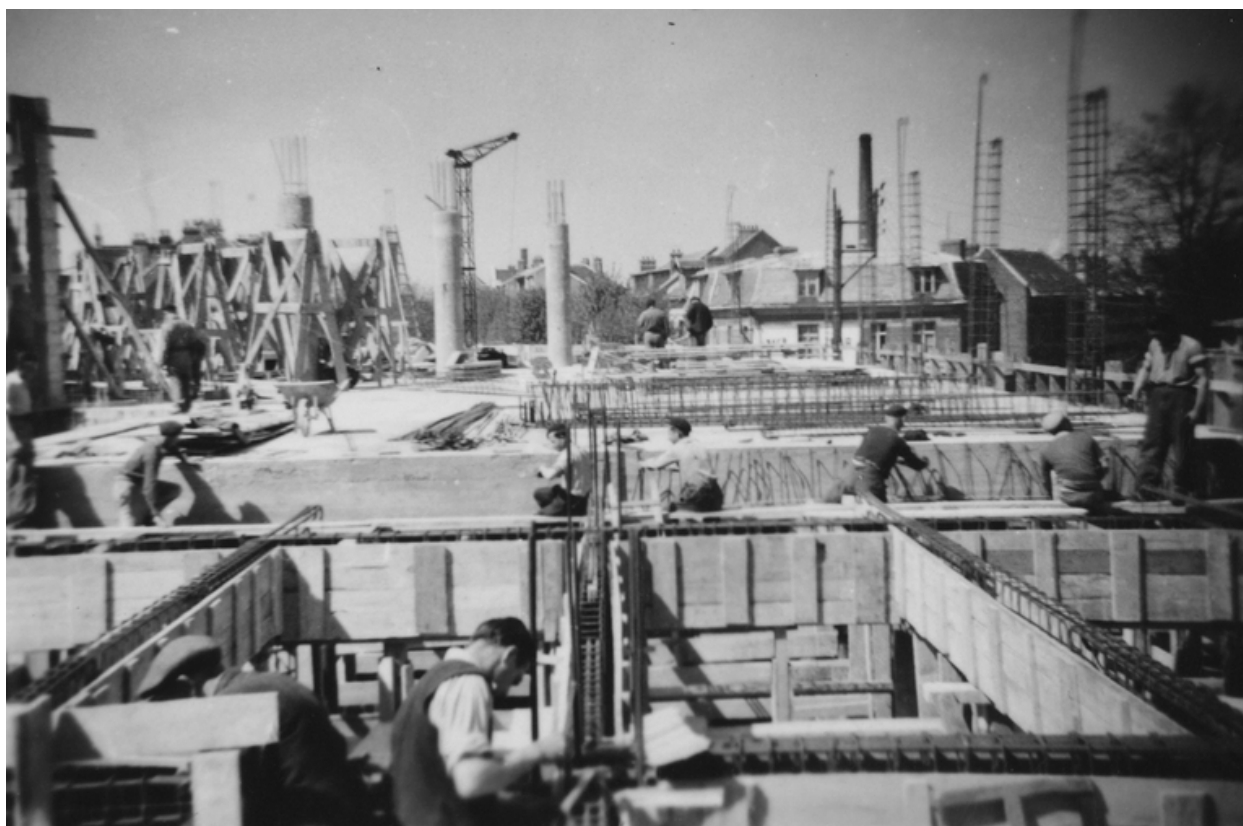
Chantier de construction des ateliers, 1948 (IFA).
