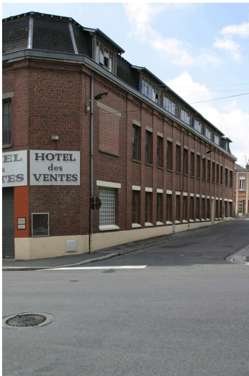
L'extension des anciens magasins rue de Mulhouse et Cité de Mulhouse construite dans l'entre-deux-guerres : façade antérieure, Cité de Mulhouse.
