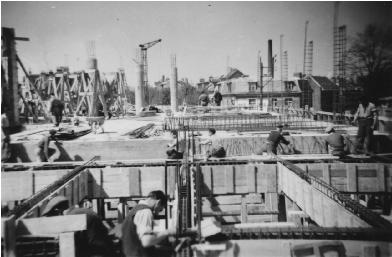
Chantier de construction des ateliers, 1948 (IFA).
