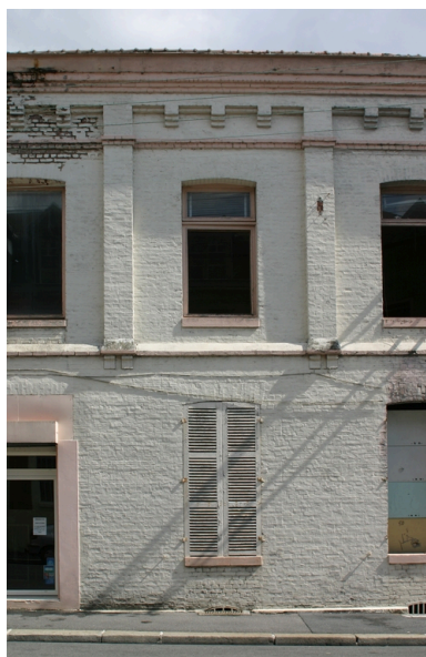
Une travée des bâtiments construits en 1887, rue de Mulhouse.
