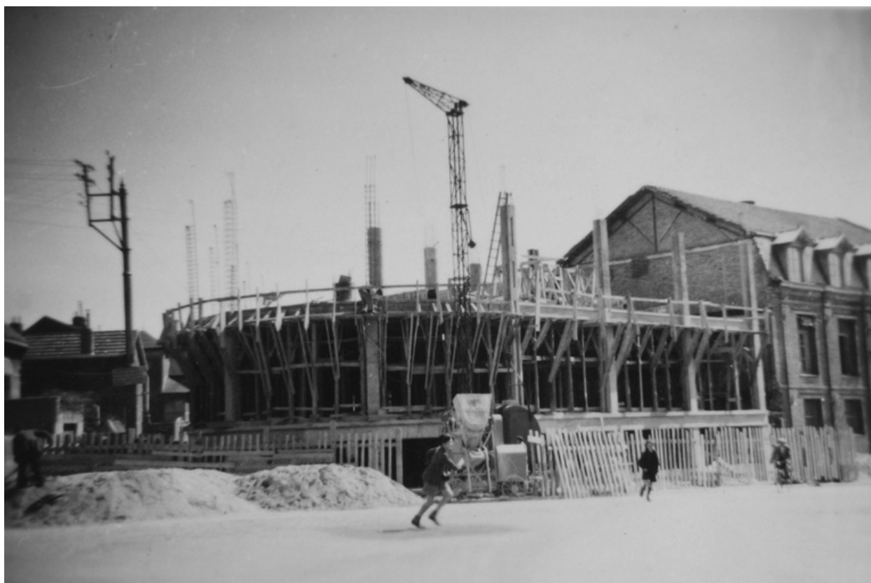
Chantier de construction des ateliers, 1948 (IFA).
