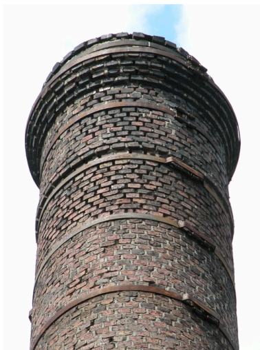
Sommet de la cheminée d'usine. Phot. Frédéric Pillet IVR22_20040200785NUCA
