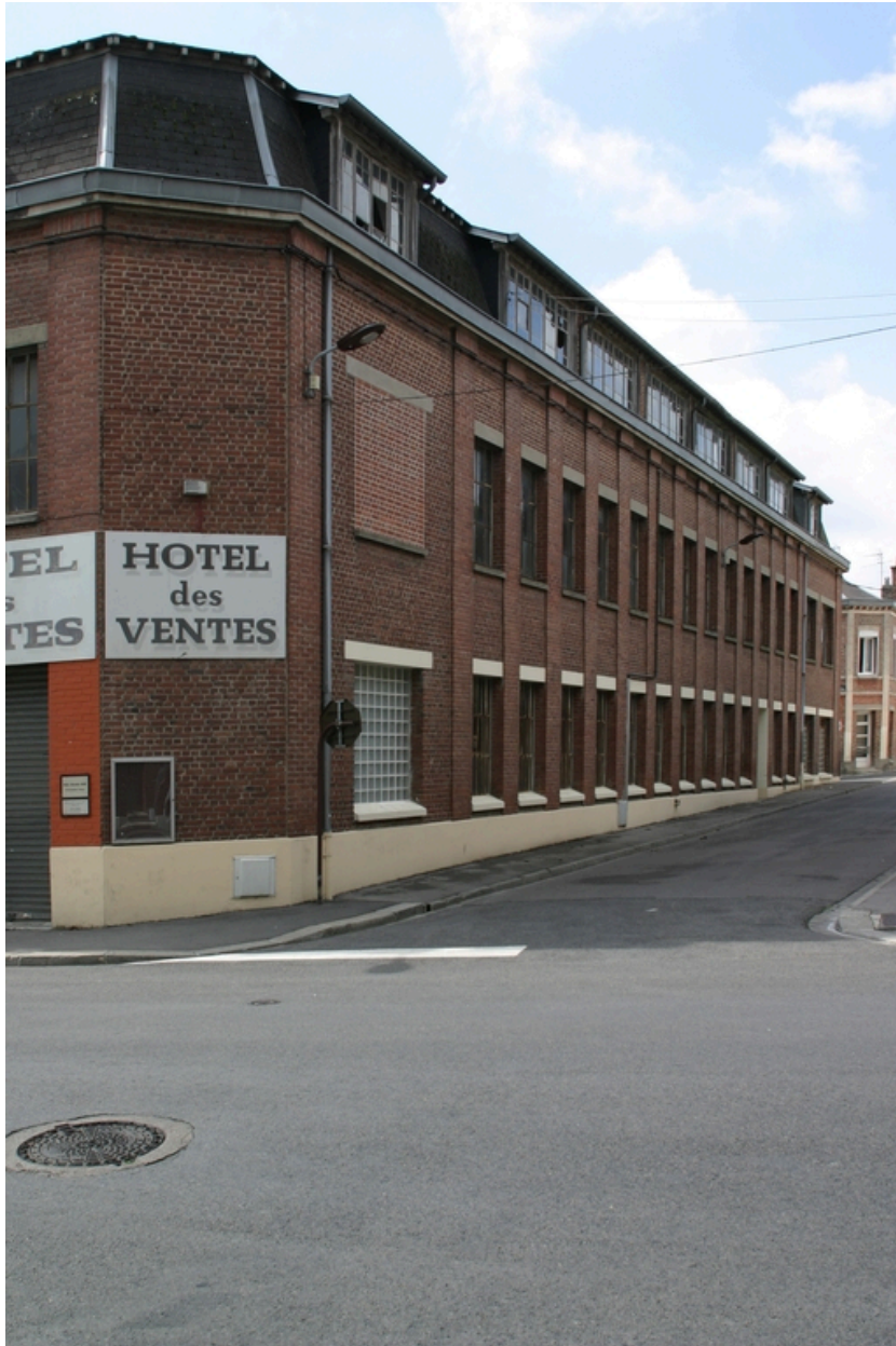
L'extension des anciens magasins rue de Mulhouse et Cité de Mulhouse construite dans l'entre-deux-guerres : façade antérieure, Cité de Mulhouse.
