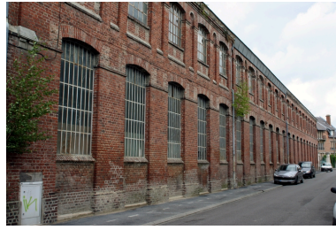
Façade des ateliers construits en 1887, rue Richard-Lenoir : atelier de fabrication de la guipure depuis 1887 (rez-de-chaussée), magasin des piqués et des échantillons (1er étage). Phot. Frédéric Pillet IVR22_20040200752NUCA
