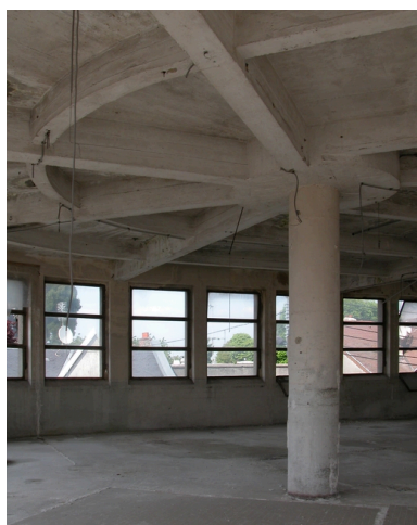
Ateliers des années 1946-48 : charpente en béton armé.
