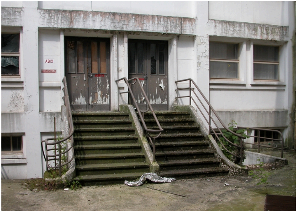
Escaliers dans la cour de l'usine.
