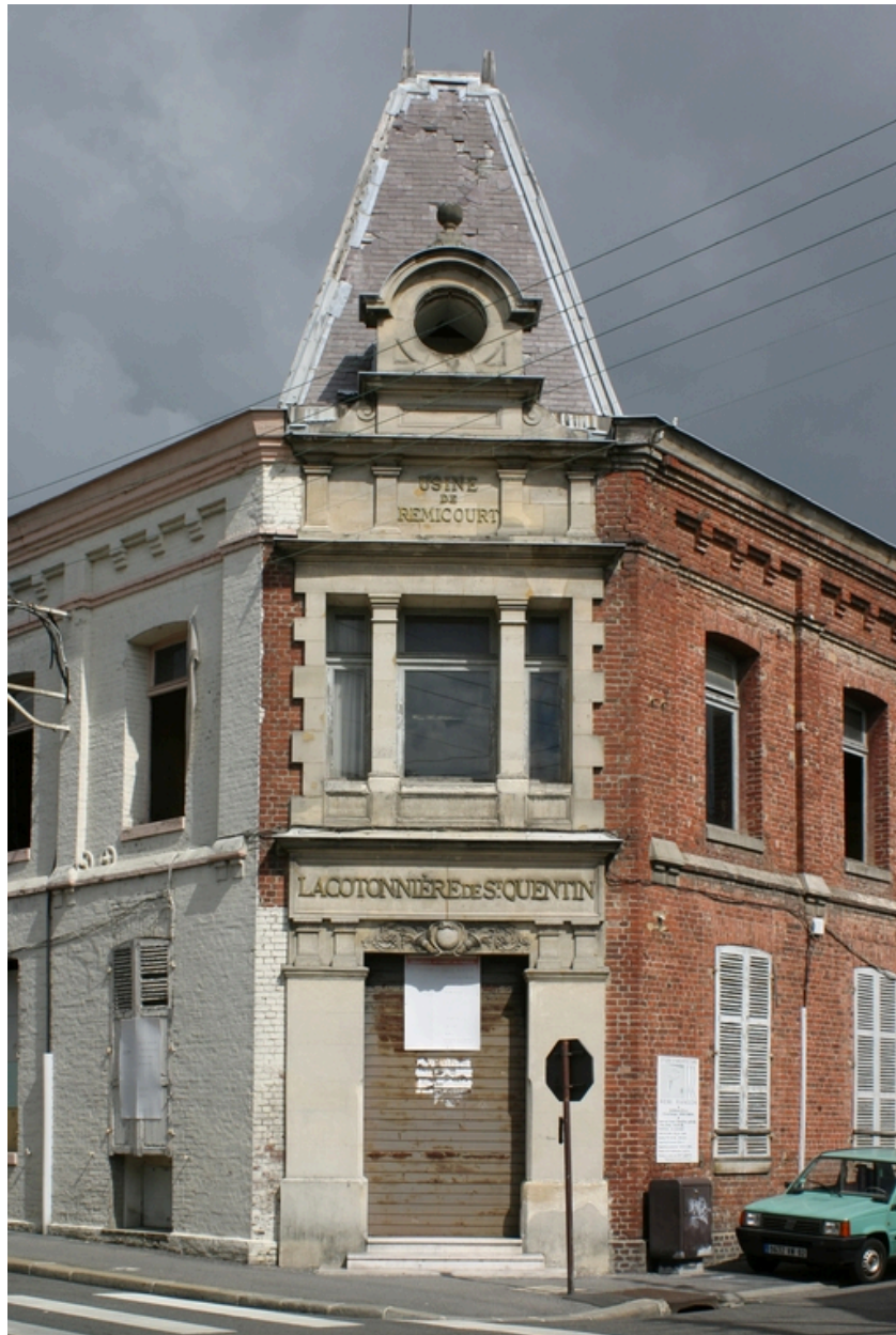
L'ancienne entrée des bureaux et magasins de vente (1887).
