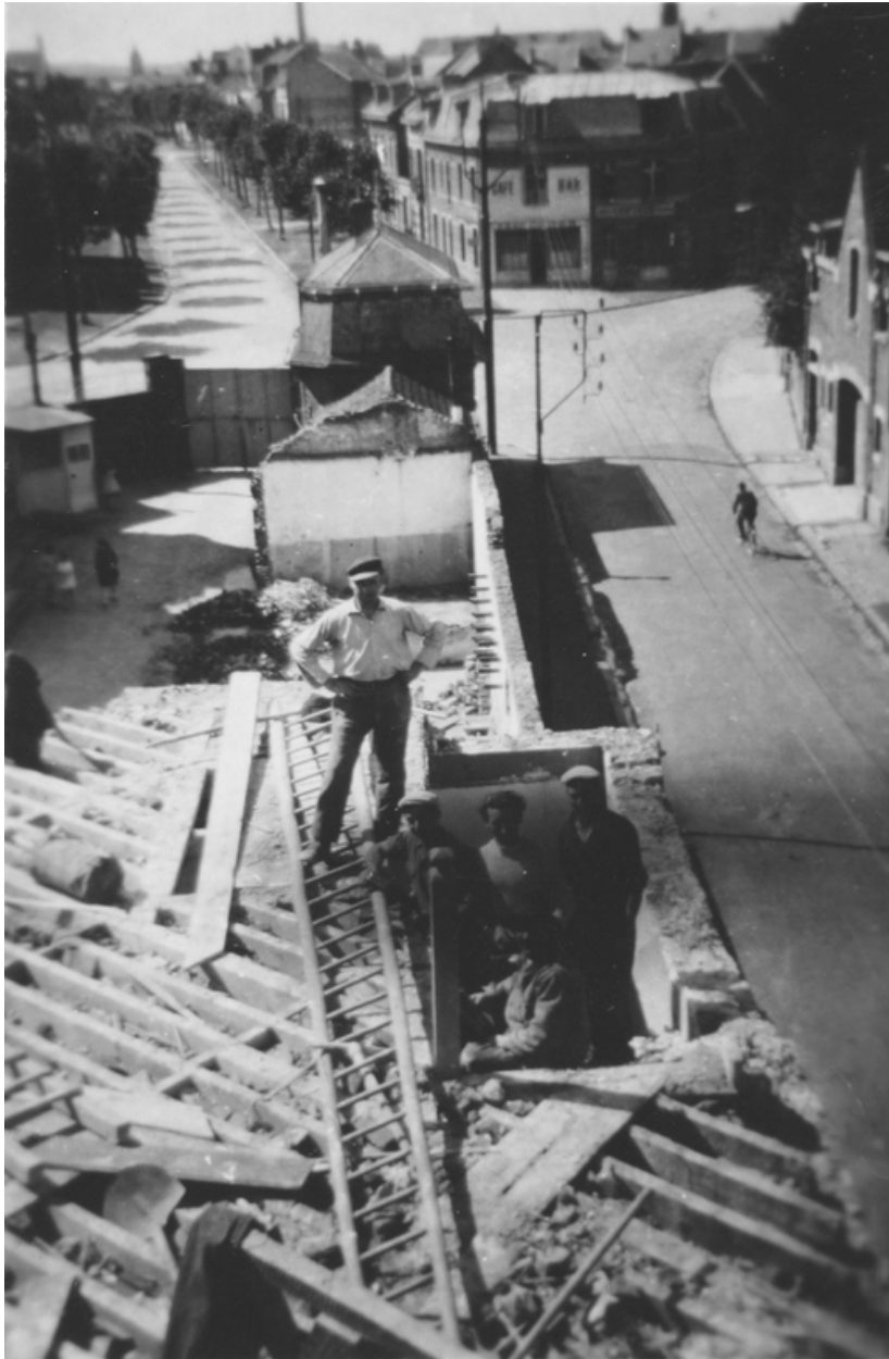
Démolition des anciens bâtiments bordant la rue Camille-Desmoulins en 1947 (IFA).
