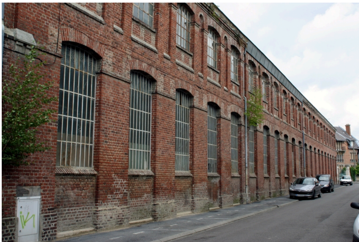
Façade des ateliers construits en 1887, rue Richard-Lenoir : atelier de fabrication de la guipure depuis 1887 (rez-de-chaussée), magasin des piqués et des échantillons (1er étage).
