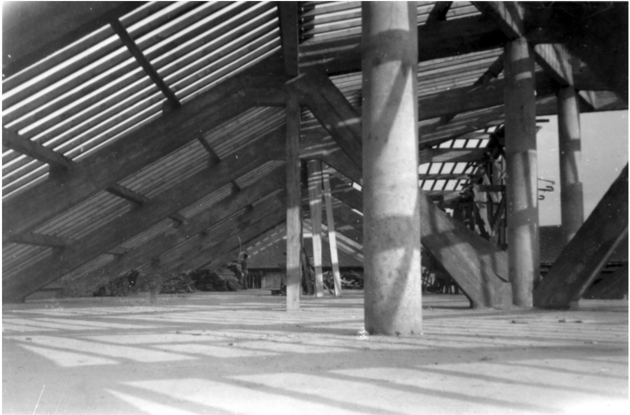
Charpente des ateliers construits en 1948 (IFA).
