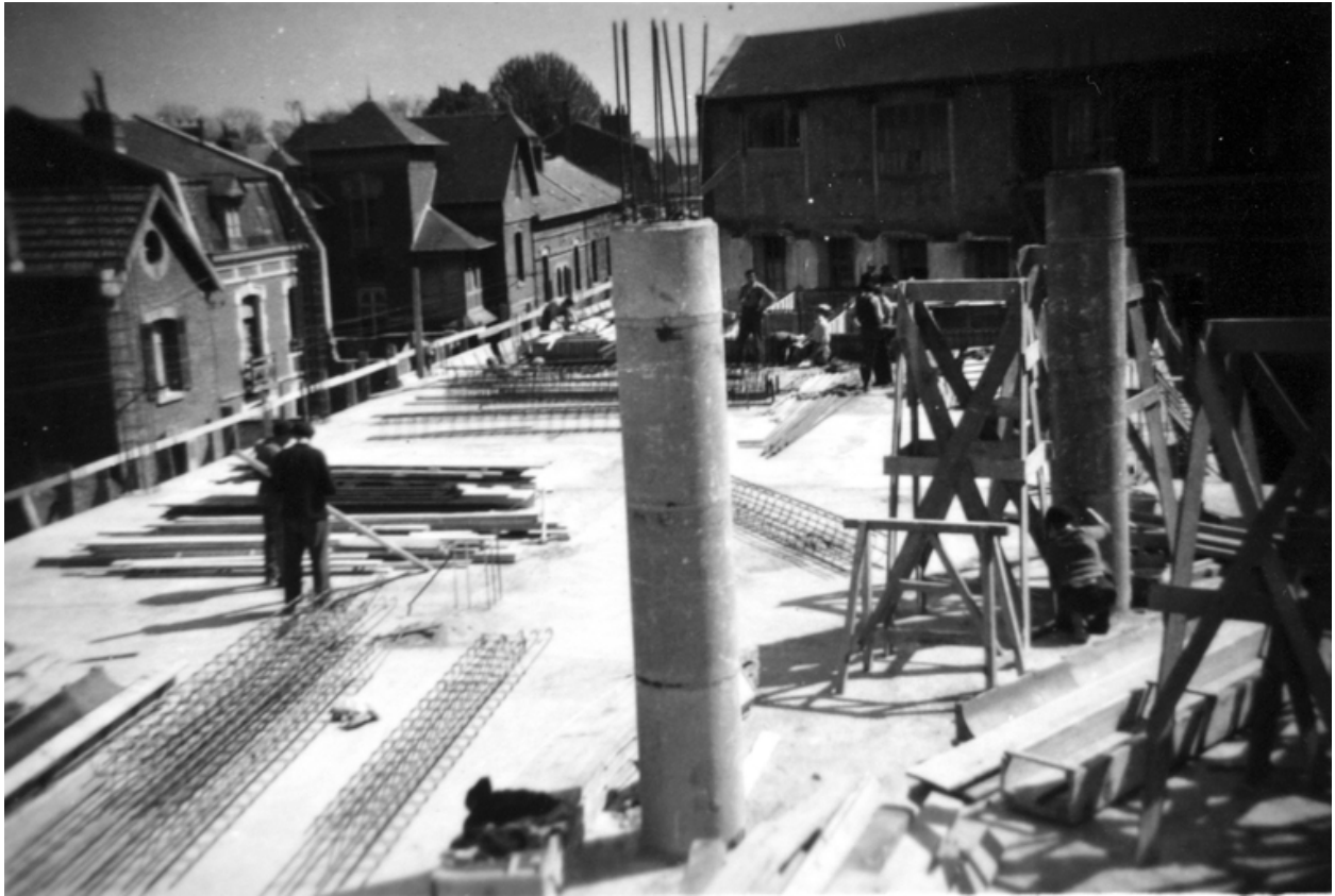
Chantier de construction des ateliers, 1948 (IFA).
