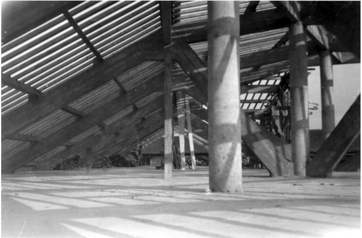
Charpente des ateliers construits en 1948 (IFA).
