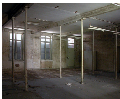
Ancien magasin à cartons pour métiers Jacquard, construit en 1887 (rez-de-chaussée).
