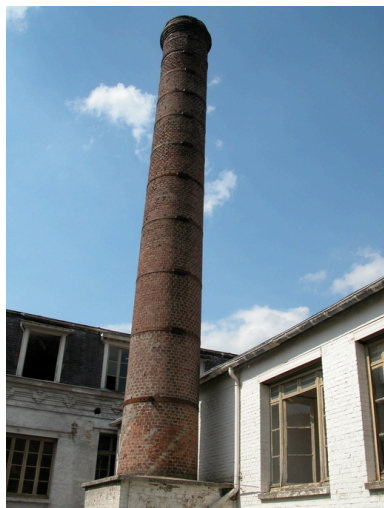
La cheminée d'usine. Phot. Frédéric Pillet IVR22_20040200784NUCA
