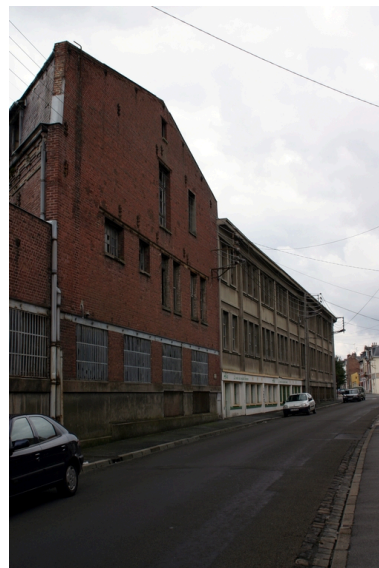
Ateliers rue Camille-Desmoulins.
