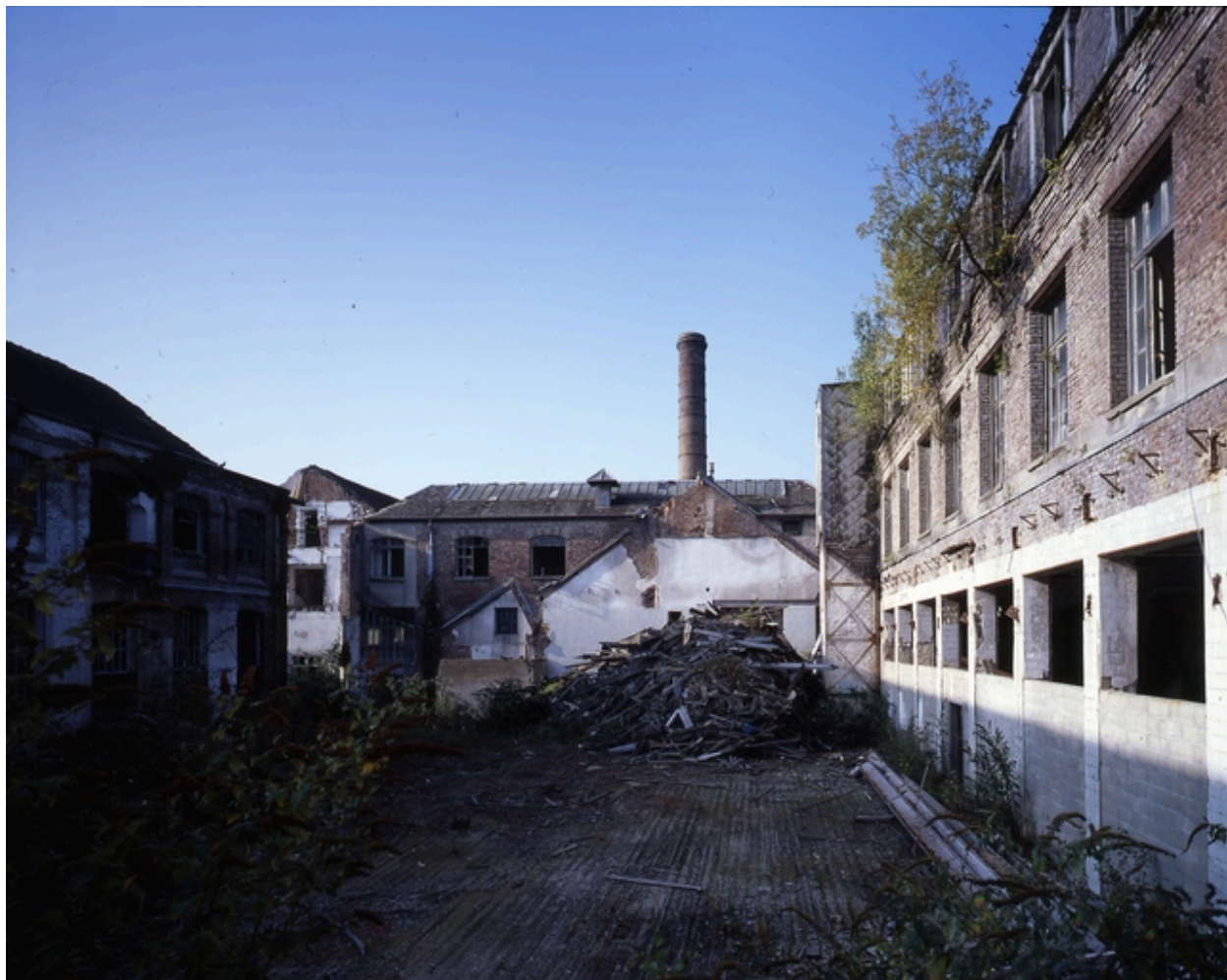
Vue des bâtiments en cours de démolition.
