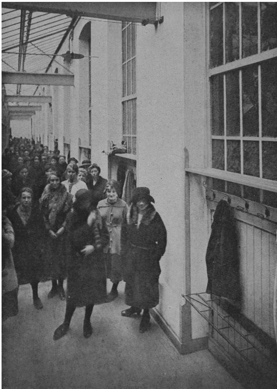
Mur gouttereau nord-ouest de l'atelier de guipure bordant la rue Richard-Lenoir, après restauration, vers 1919 (Le Monde Illustré).
