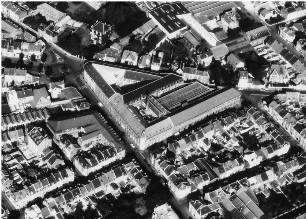
Vue aérienne de l'Usine de Remicourt depuis le sud, en 1989.
