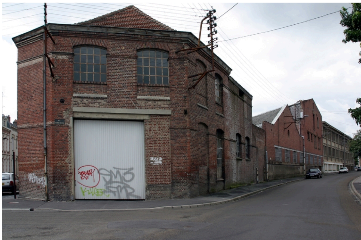
L'usine de Remicourt, à l'angle des rue Richard-Lenoir (à gauche) et Camille-Desmoulins (à droite) : au premier plan, la forge des années 1920.
