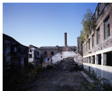
Vue des bâtiments en cours de démolition. Phot. Thierry Lefébure IVR22_20070200065VA
