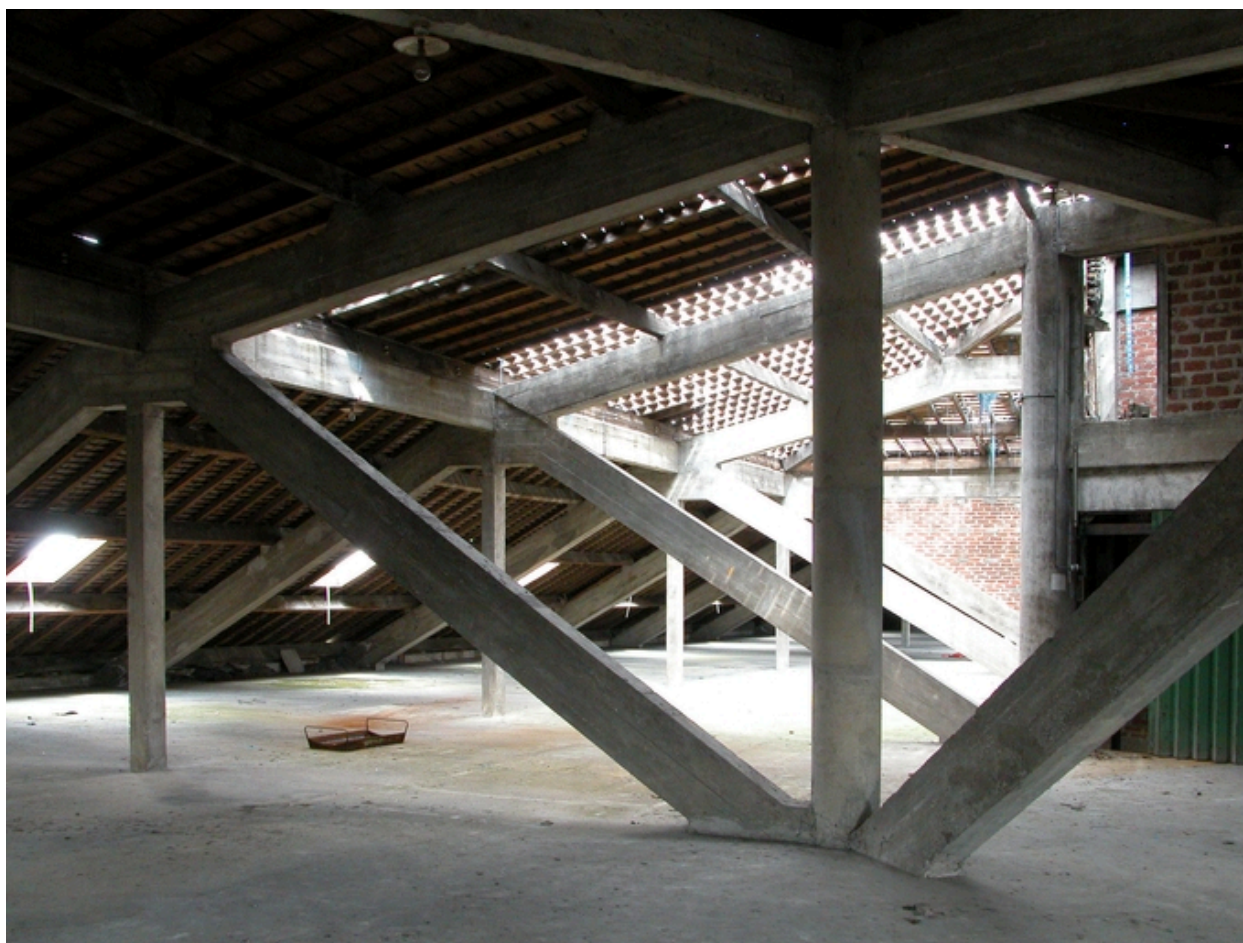
Ateliers des années 1946-48 : charpente en béton armé.
