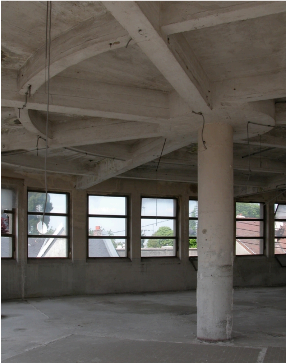
Ateliers des années 1946-48 : détail du système poteau-poutre de la structure en béton armé.
