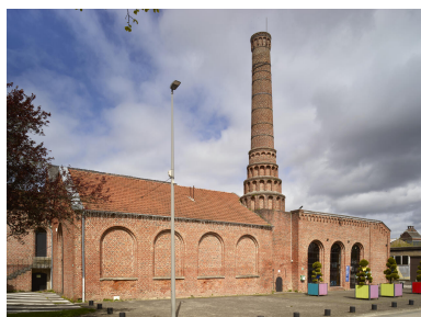
Fourmies, ancienne filature de laine Douvin, puis Masurel, transformée en écomusée de l'industrie textile.
