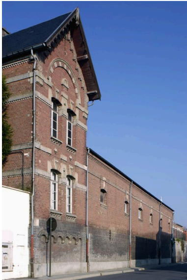
Communs du château. Phot. Thierry Lefébure IVR22_20058000079NUCA
