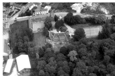
Vue aérienne depuis l'est. Phot. Isabelle Barbedor IVR22_20048010650NUCA
