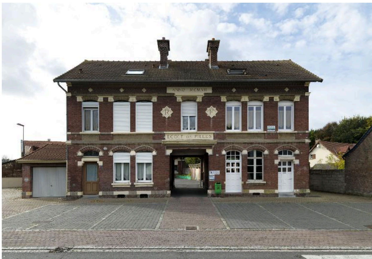
Vaudricourt - Ancienne "boutique" de serrurier.
