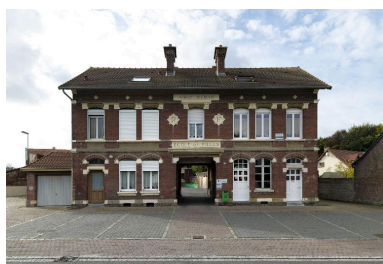
Vaudricourt - Ancienne "boutique" de serrurier. Phot. Thierry Lefébure IVR22_20148000660NUC2A
