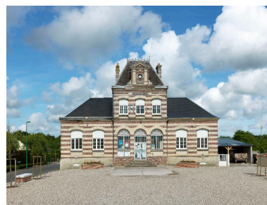
Embreville - Ancienne école, mairie et logement, actuellement mairie et école. Phot. Thierry Lefébure IVR22_20138000260NUC2A
