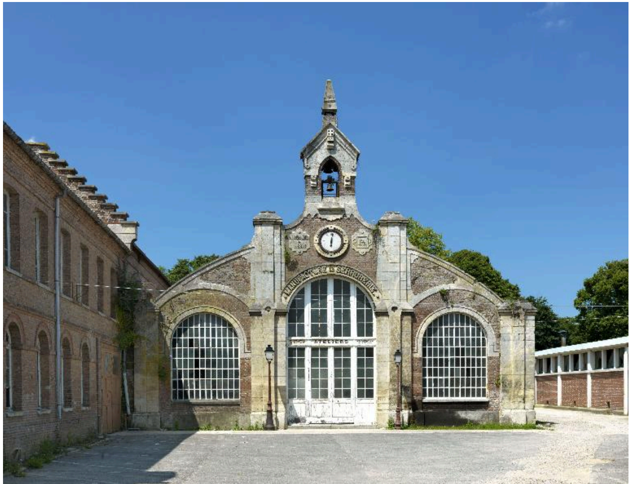
Friville-Escarbotin - Usine de serrurerie Maquennehem et Imbert, puis Imbert Ricquier, puis Bricard.
