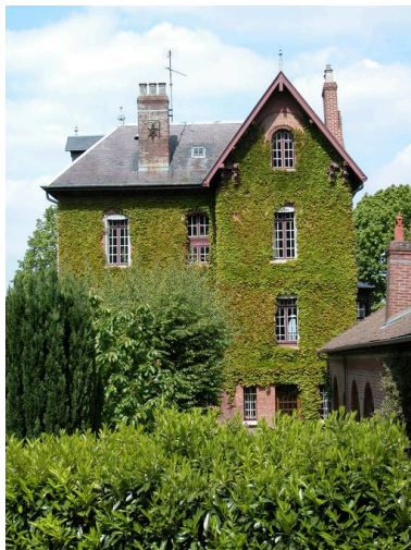
Elévation postérieure. Phot. Elisabeth Justome IVR22_20058002858NUCA
