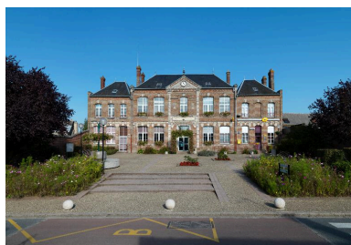
Vue d'ensemble. Phot. Thierry Lefébure IVR22_20128000868NUC2A
