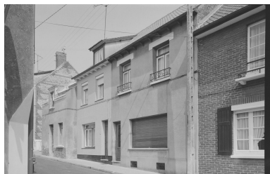
Vue générale de la maison du n°6 (au premier plan) depuis la rue.
