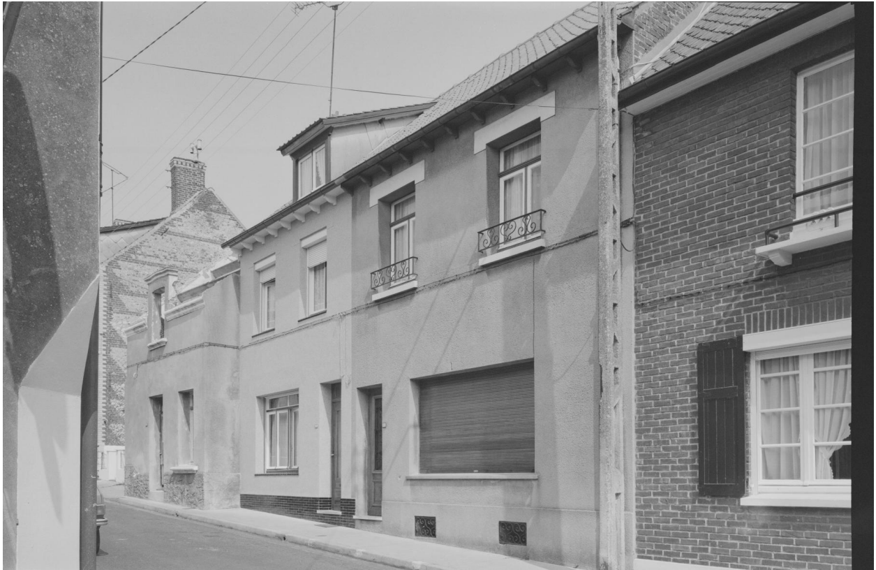
Vue générale de la maison du n°6 (au premier plan) depuis la rue.
