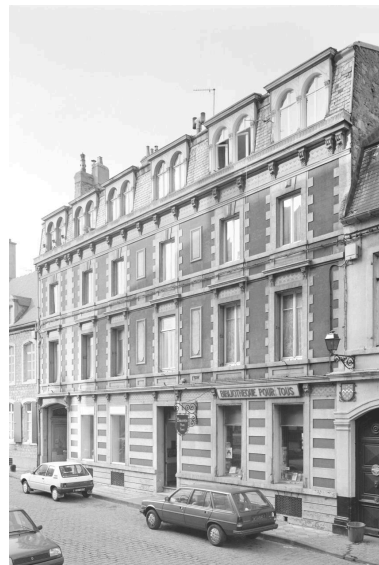
Façade sur voir. Phot. Jean-Michel Périn IVR31_19886205150X
