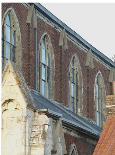
Fenêtres hautes de la nef : mur en brique et encadrements des baies et chapérons des contreforts en pierre calcaire
