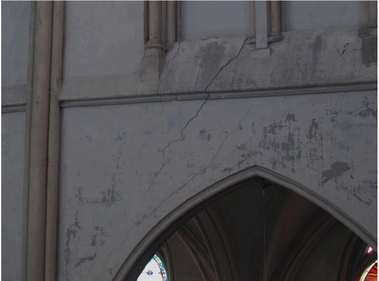
Haut d'une grande arcade (mur nord de travée ouest) : fissure en écoinçon
