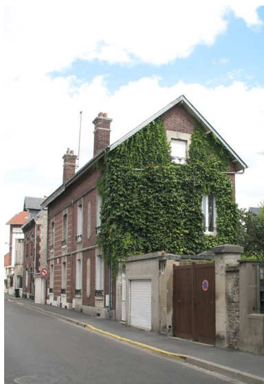
Vue générale de la villa Suzanne (au premier plan), jumelée à la villa Juliette. Phot. Clarisse Lorieux IVR22_20096005127NUCA
