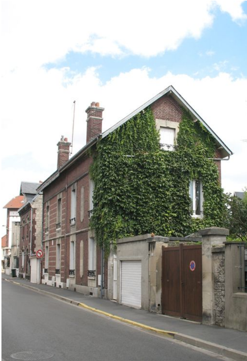
Vue générale de la villa Suzanne (au premier plan), jumelée à la villa Juliette.
