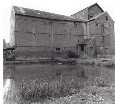
Vue d'ensemble de la minoterie.
