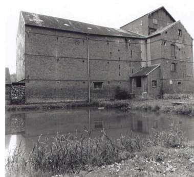
Vue d'ensemble de la minoterie. Phot. Thierry Lefébure IVR22_20026000992X
