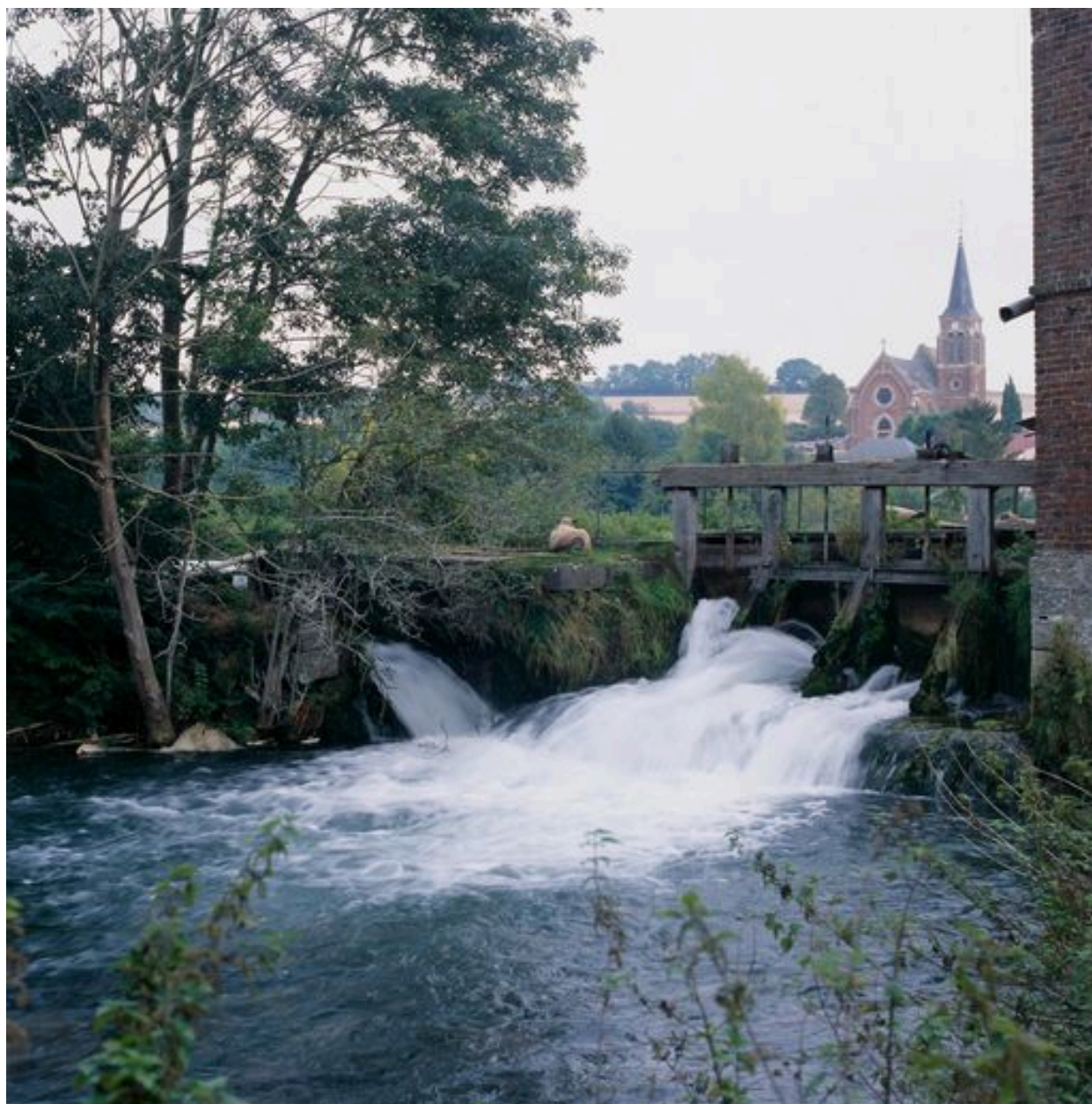
Le vannage de décharge.
