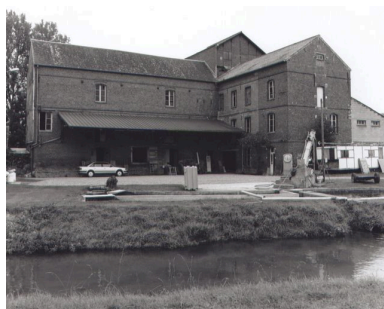
Ensemble sur cour de la minoterie. Phot. Thierry Lefébure IVR22_20026000998X
