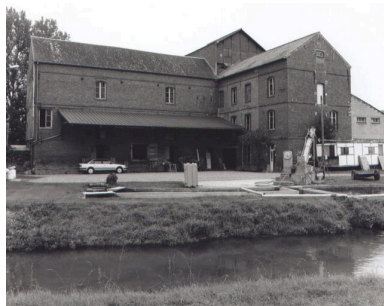
Ensemble sur cour de la minoterie.
