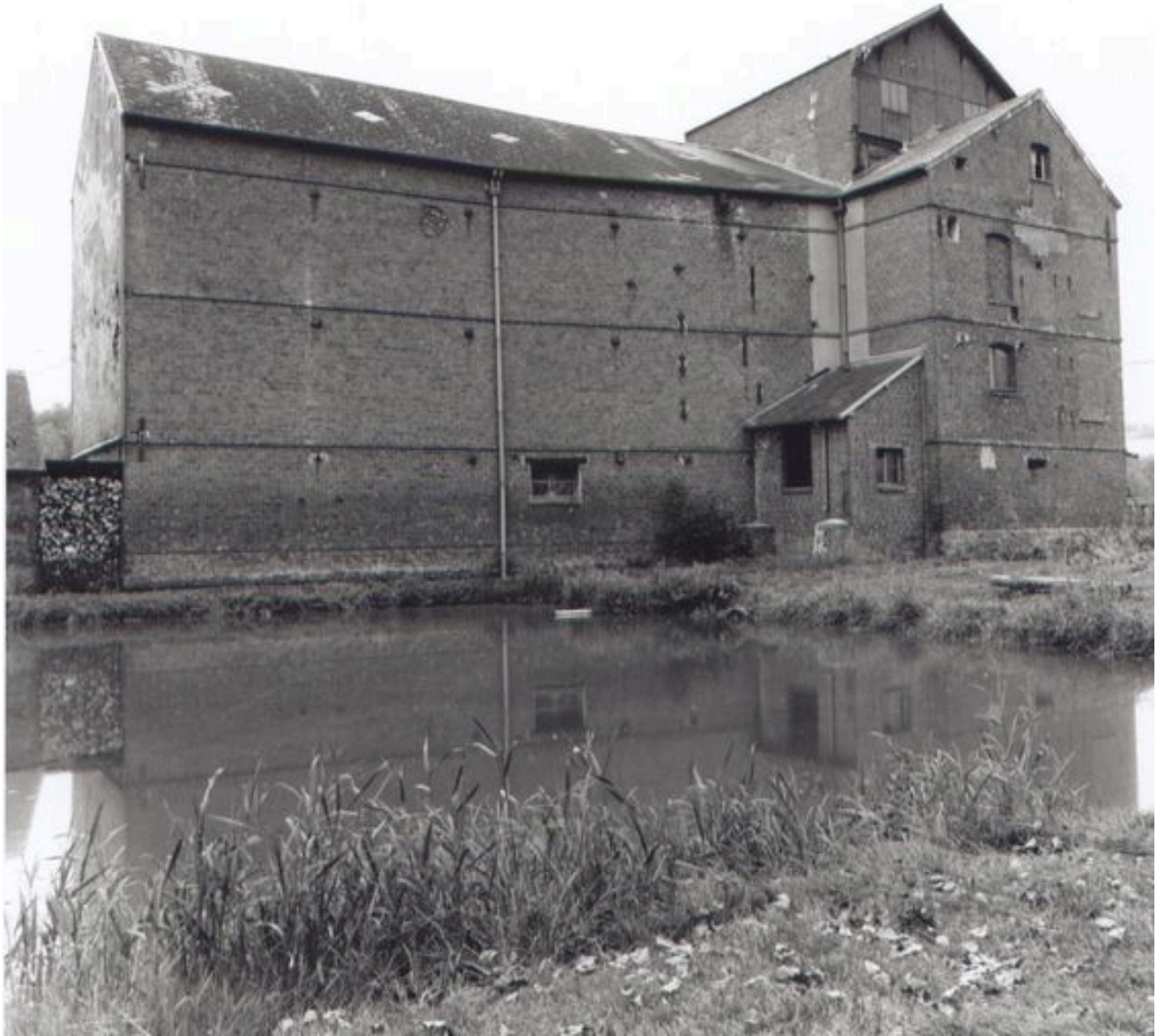
Vue d'ensemble de la minoterie.
