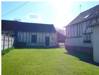
Vue de la grange et des étables depuis la cour. Phot. Inès Guérin IVR22_20078005741NUCA
