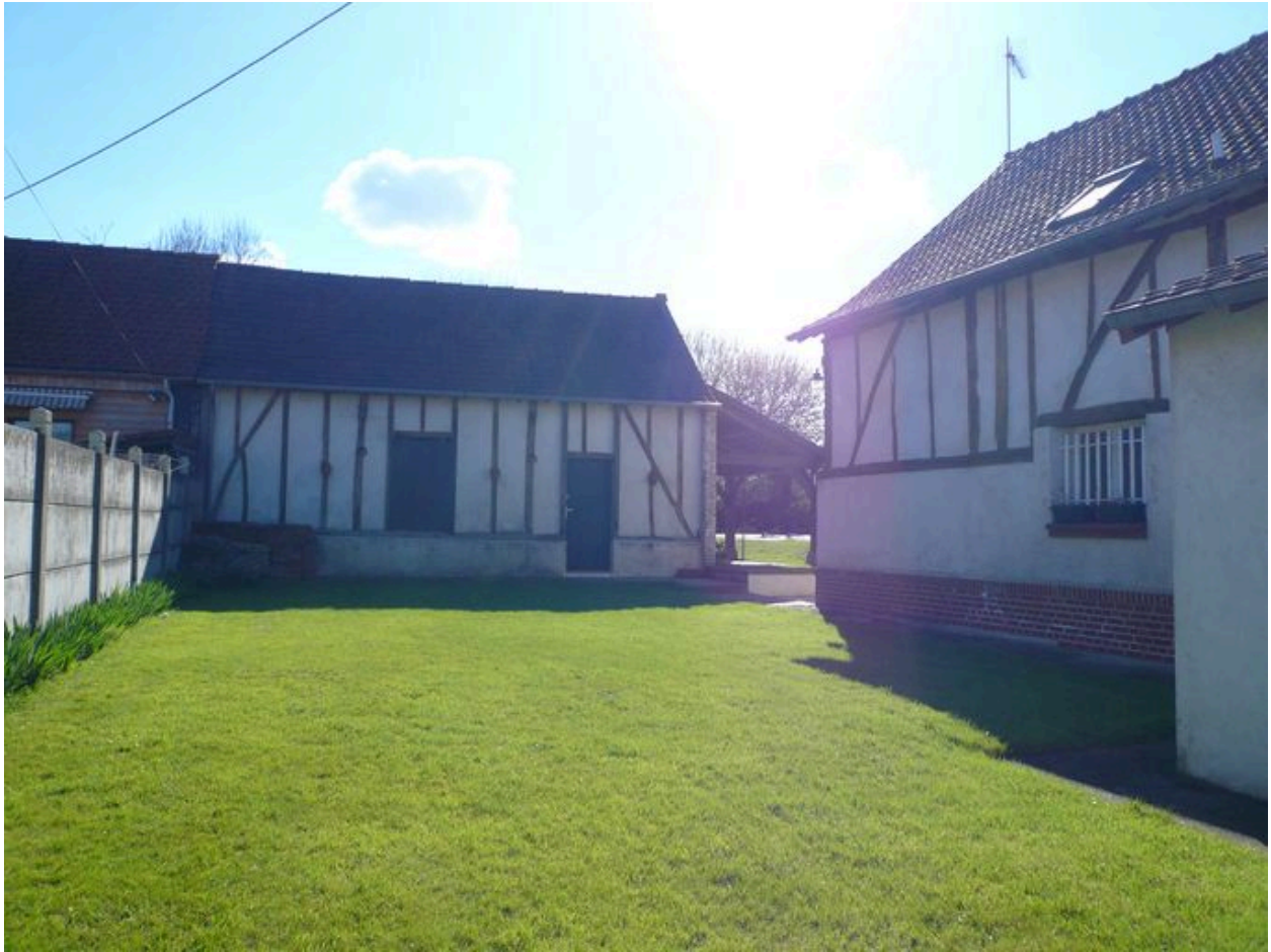
Vue de la grange et des étables depuis la cour.
