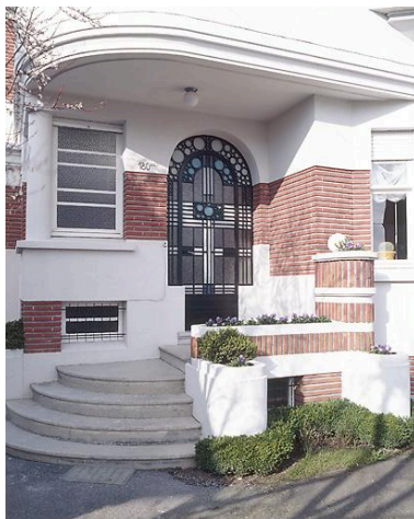
Détail de l'entrée. Phot. Olivier Marlard IVR31_19955900655XA
