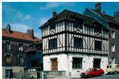
Vue générale. Phot. Jean-Michel Perrin IVR22_19856000648ZA
