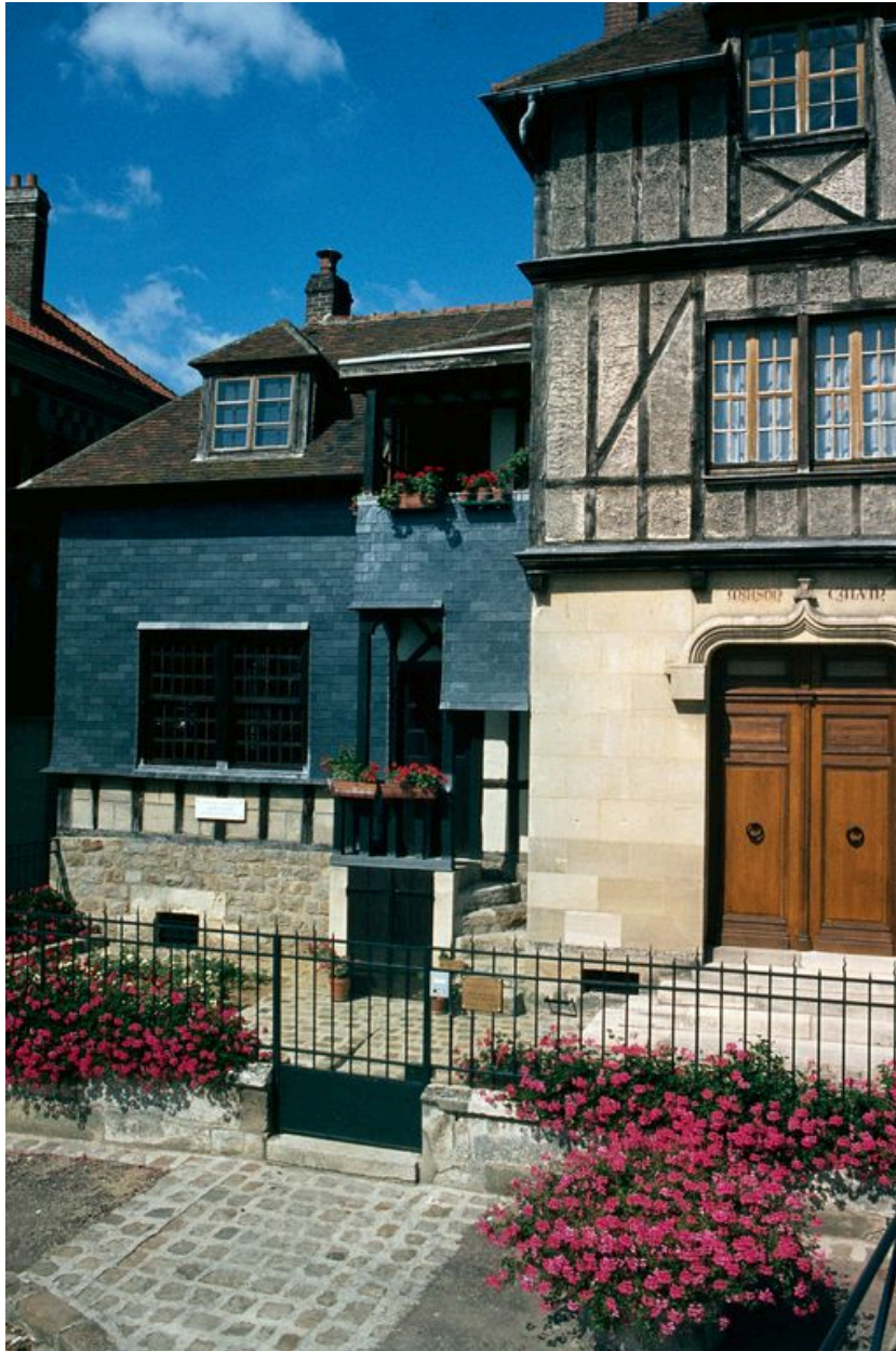
Vue partielle de l'élévation antérieure.
