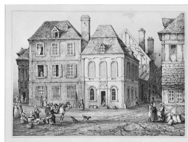
Vue ancienne (Société des Antiquaires de Picardie, Amiens ; fonds Pinsard). Phot. Jean-Michel Périn IVR22_19846000114XB
