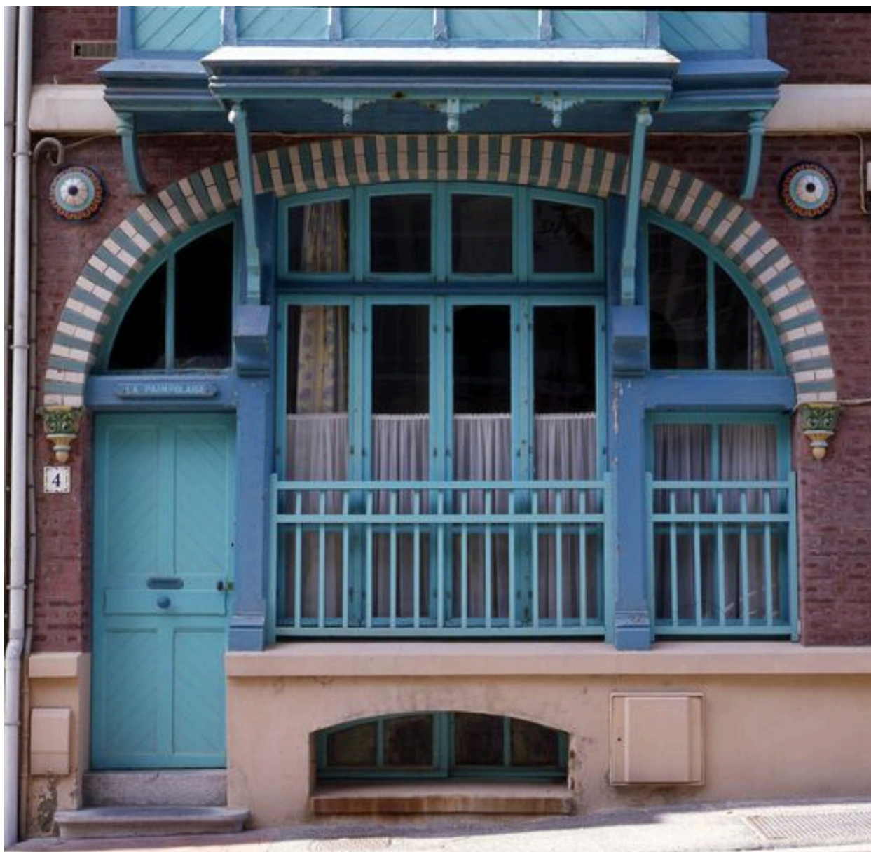
Détail du rez-de-chaussée.
