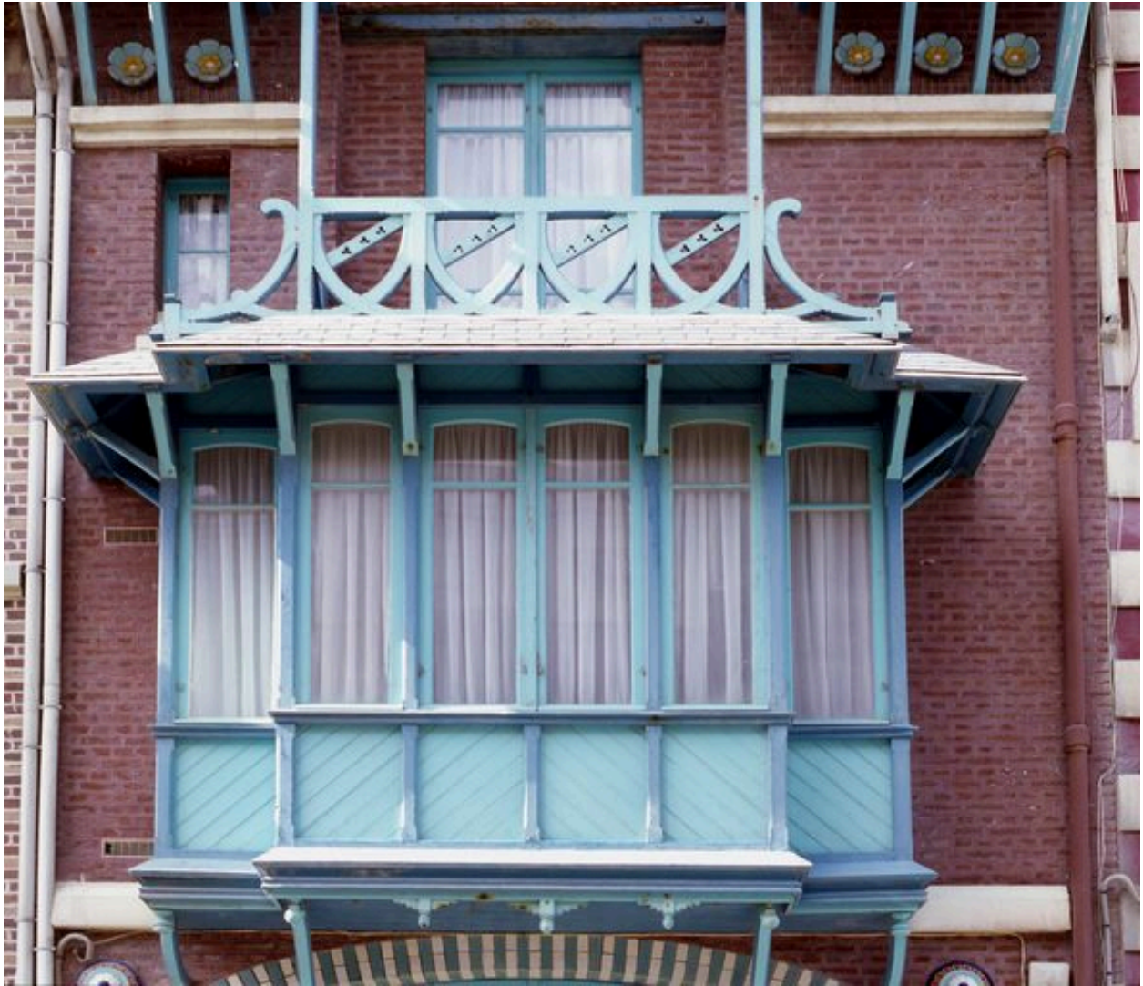
Détail du bow-window en surplomb.
