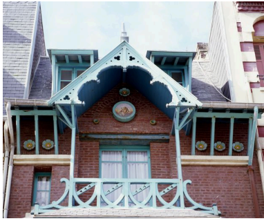
Détail de la partie supérieure de l'élévation.
