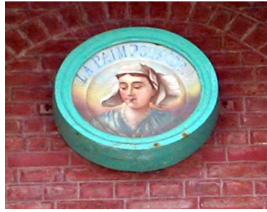
Détail du médaillon portant appellation.
