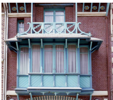
Détail du bow-window en surplomb. Phot. Marie-Laure Monnehay-Vulliet IVR22_20048000364XA
