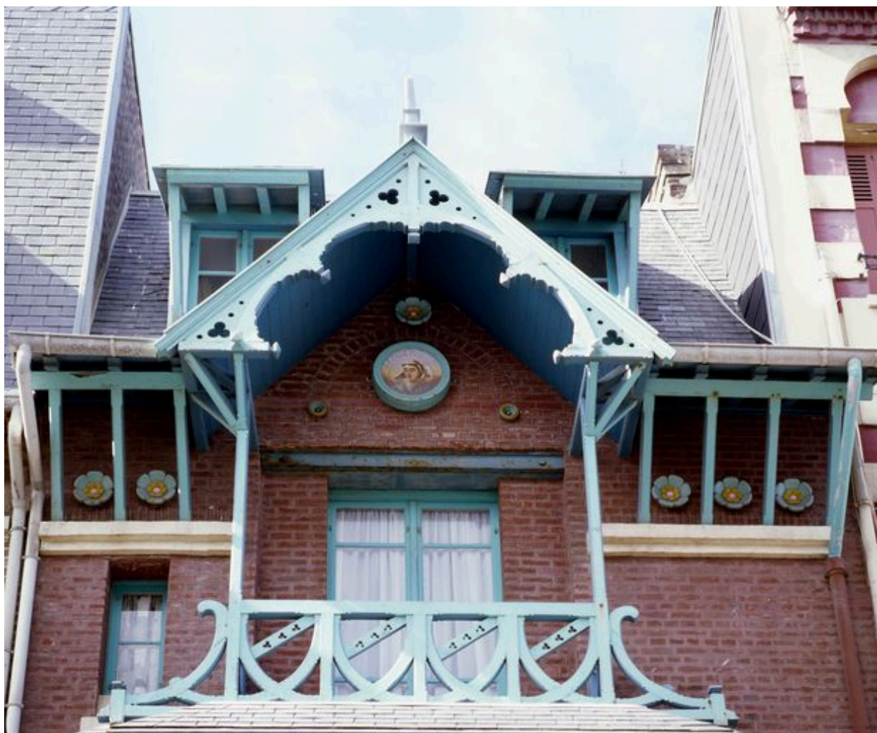
Détail de la partie supérieure de l'élévation.
