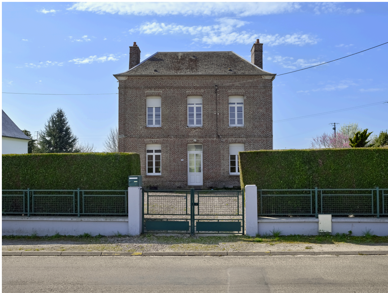
Vue nord du presbytère, depuis la route.
