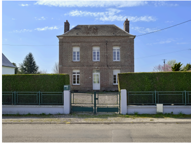
Vue nord du presbytère, depuis la route. Phot. Thierry Lefébure IVR32_20258001585NUCA
