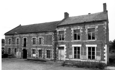
Vue de la façade du bâtiment principal. Phot. Thierry Lefébure IVR22_19920201211Z
