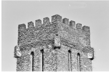
Couronnement. Phot. Michèle Rougier IVR31_19856200516Z
