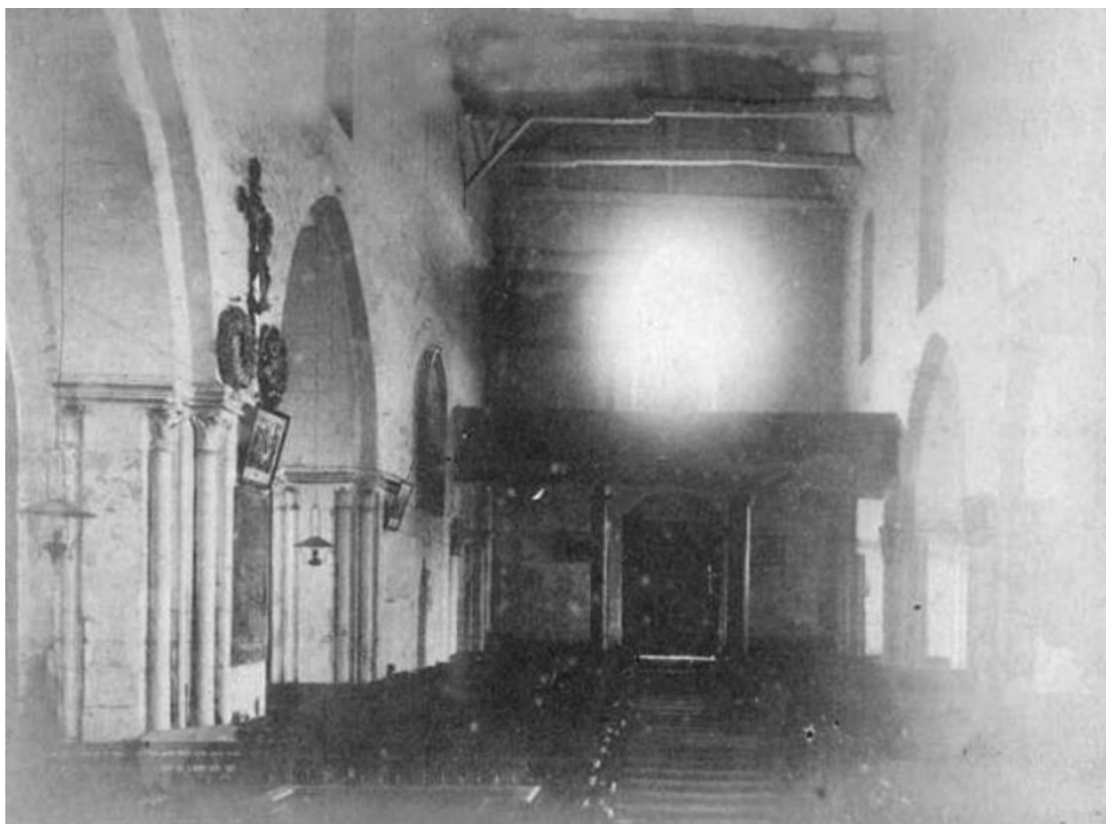
Intérieur de la nef vers l'ouest.
