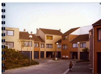
îlot 2, 1978. Le béton arbore des ocres qui tranchent avec le bleu foncé des menuiseries (AC Villeneuve d'Ascq, 16W3). Repro. Pierre Thibaut
