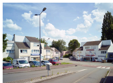
L'accès de l'îlot, en léger contrebas de l'avenue Champollion, accueillant commerces et stationnement. Phot. Pierre Thibaut IVR32_20185900664NUCA
