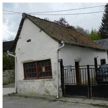
Atelier de serrurerie, rue de Bas. Phot. Romain Grimaud IVR22_20128005009NUC2A
