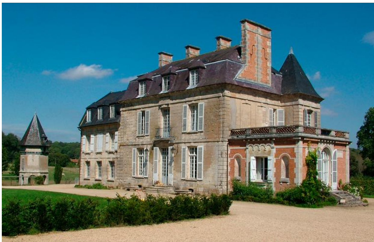
Vue de l'élévation antérieure.
