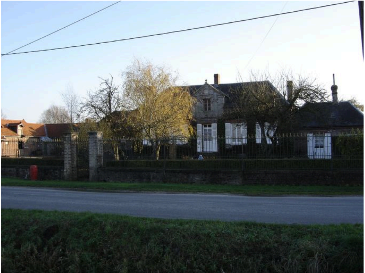
Vue d'ensemble de la façade du logis.
