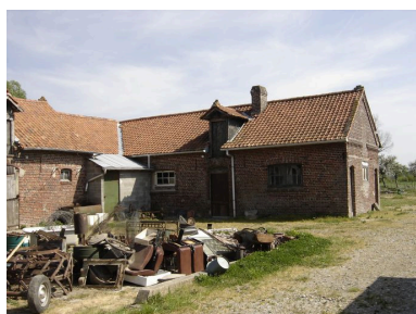
Vue des étables au sud-est de cour. Phot. Inès Guérin IVR22_20078005959NUCA
