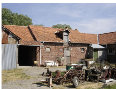
Vue des étables à l'est de la cour. Phot. Inès Guérin IVR22_20078005960NUCA
