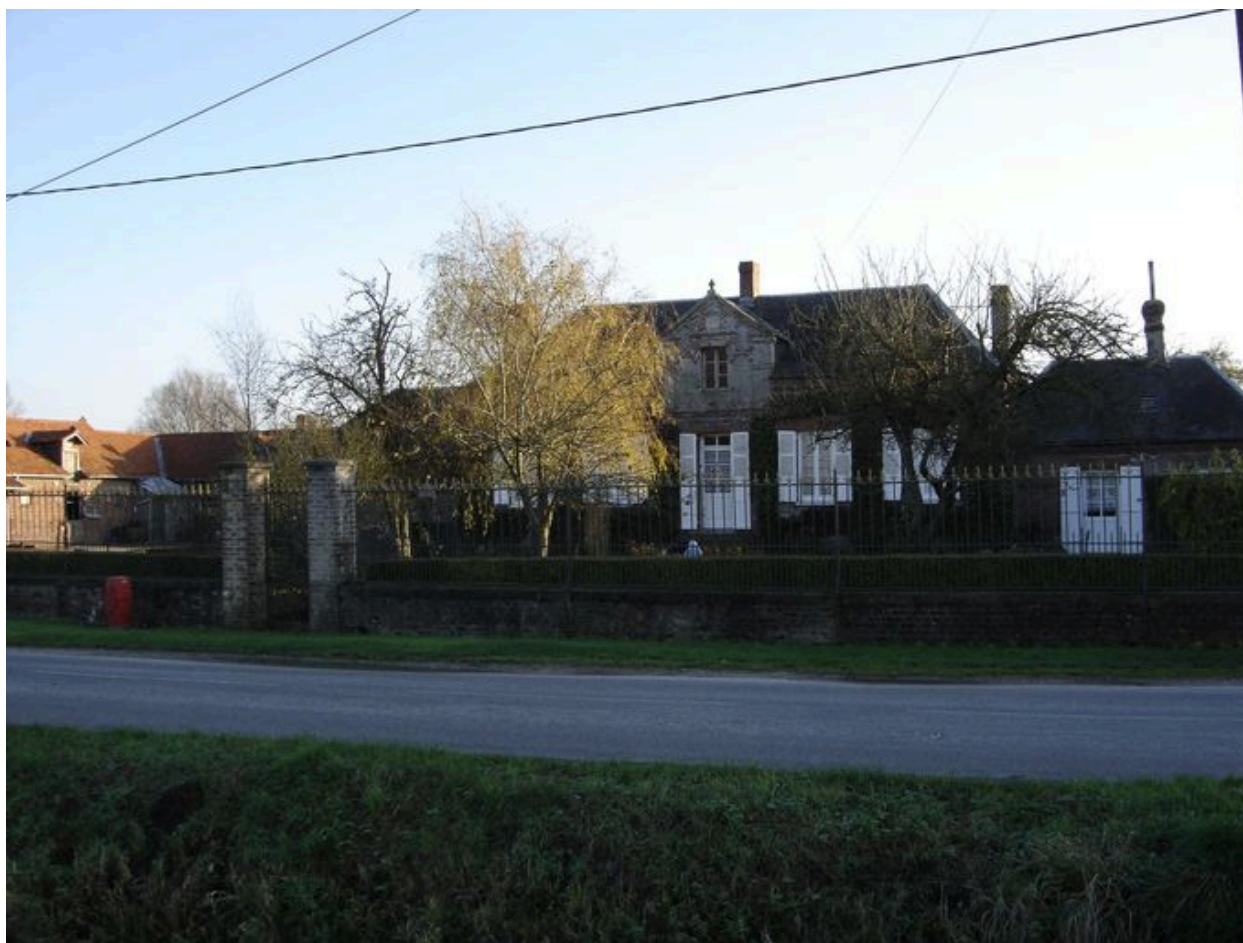
Vue d'ensemble de la façade du logis.
